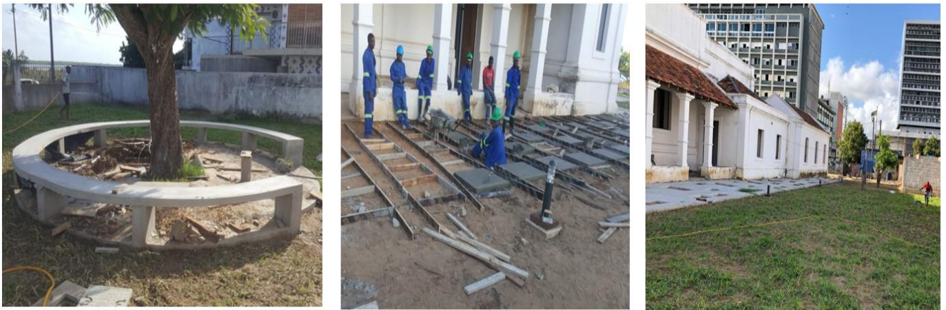
Figura 5: Arranjos Paisagísticos exterioris (construção de bancadas, placas de passeios e plantio de relva)
