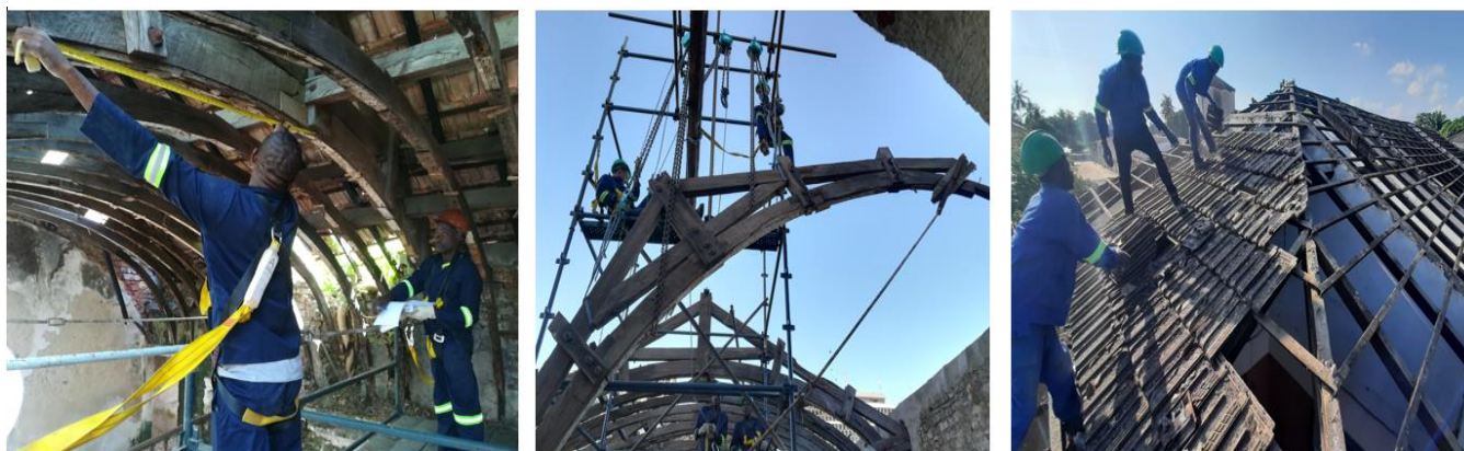
Figura 3: Medição, retirada da Estrutura de cobertura antiga e colocação de telhas
