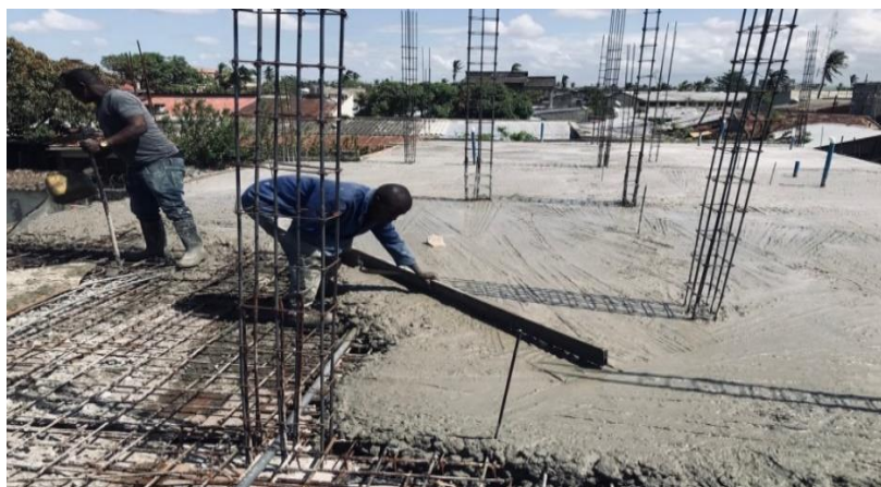
Figura 11: Betonagem de lajes Maciças
