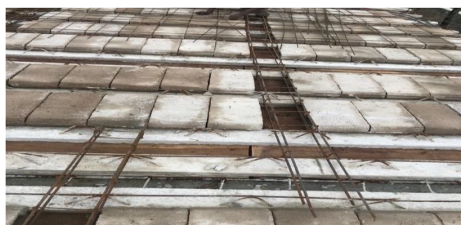
Figura 20: Processo de implantação de tarugos em lajes aligeiradas
