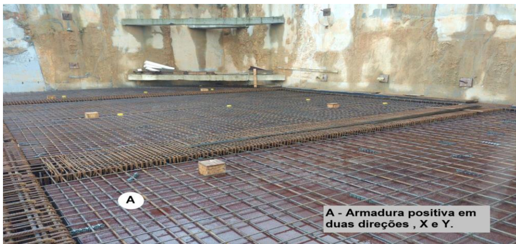
Figura 9: Armadura positiva da laje maciça
