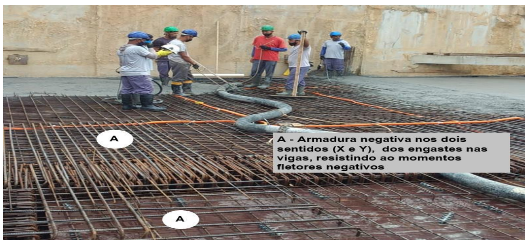
Figura 10: Armadura negativa da laje maciça
