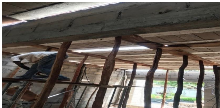
Figura 18: Abobadilha como cofragens perdidas
