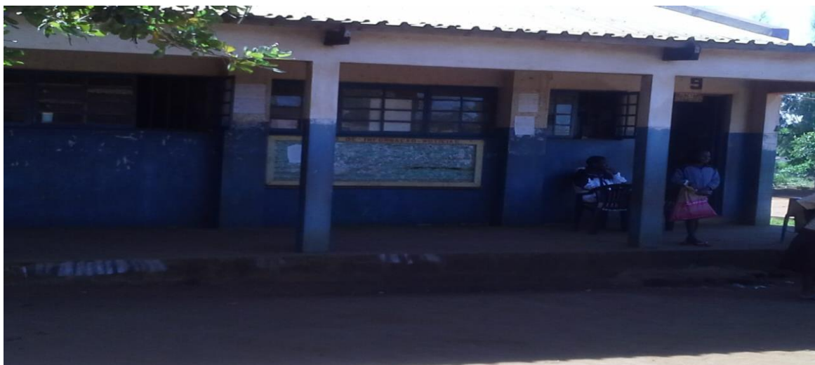
Figura 2: Edifício onde funciona o bloco administrativo da escola
