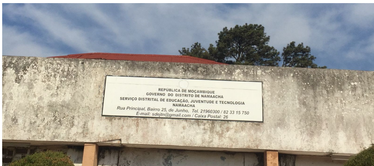
Figura 1: Serviços Distrital de Educação 1
