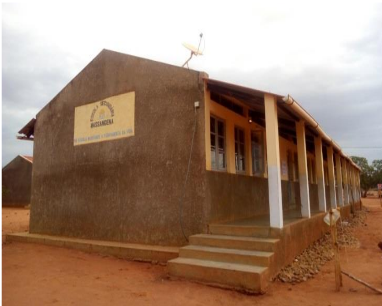
Fig. 2. Apresentação parcial de bloco de salas de aulas
