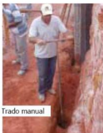
Figura 7 - Execução de estaca tipo broca
