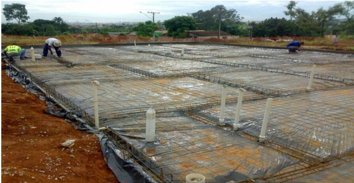
Figura 4 -Processo de impermeabilização de fundação tipo radier
