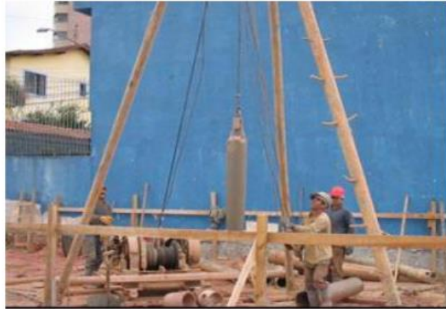
Figura 8 - Execução das estacas tipo Strauss com cravação da piteira
