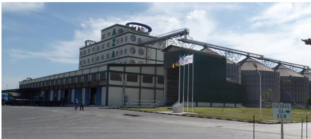
Fig. 5: Vista frontal-lateral da fábrica de moagem de trigo e silos
