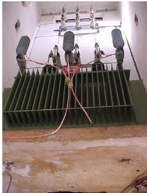
Figura 34: Montagem de DST directamente na Cuba do PTCA
