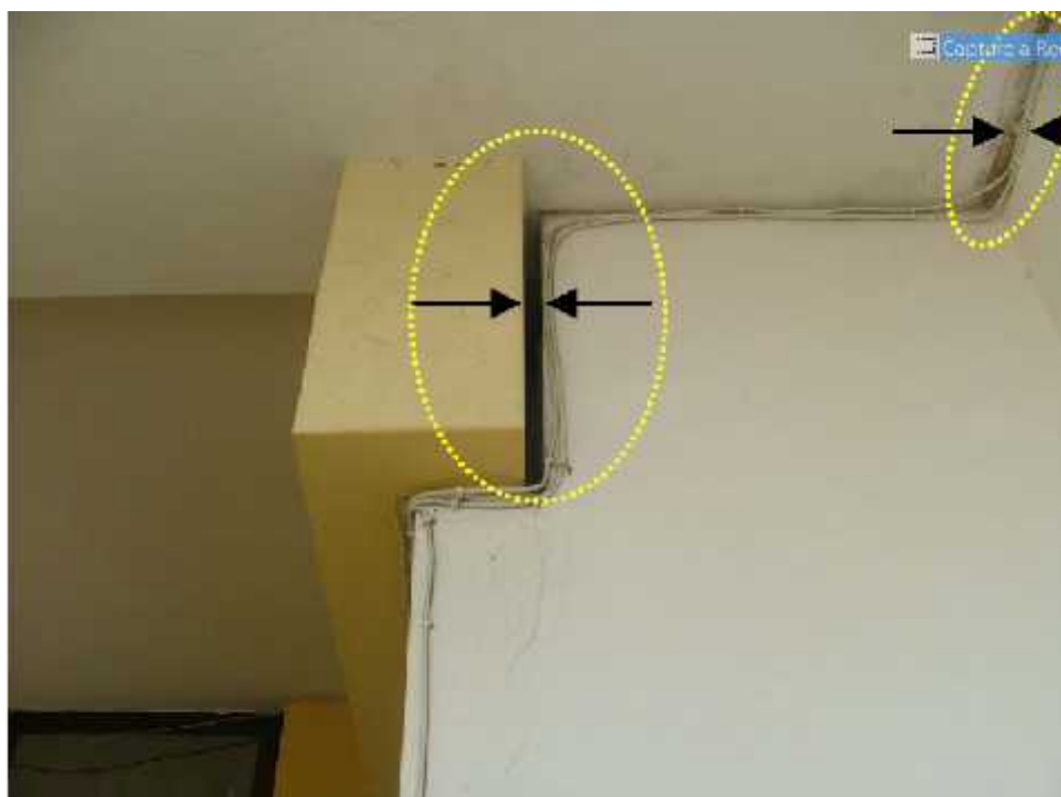
Figura 62 – Separação de elementos de construção.
