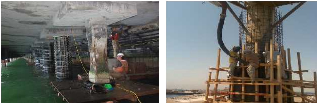
Figura 5 – Encamisamento com betão armado.
