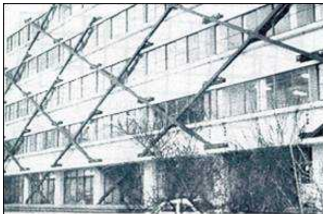
Figura 2 - Adição de contraventamento metálico.
