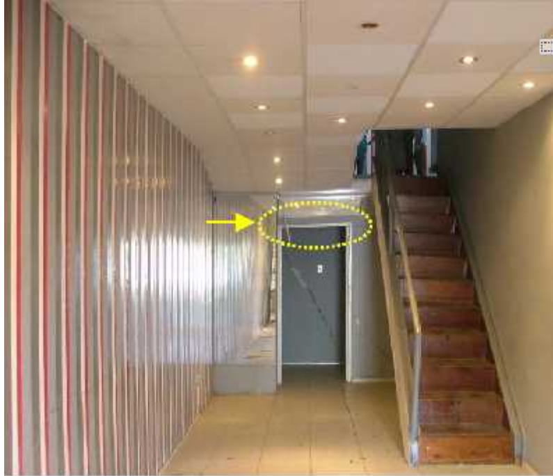
Figura 36 – Empenamento da caixilharia e da escada de acesso ao piso superior da loja.
