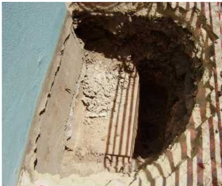
Figura 6 -. Exemplo de sondagem para averiguar a profundidade e estado das fundações existentes (Arquivo de imagem e fotográfica da empresa JetSJ geotécnica,lda).
