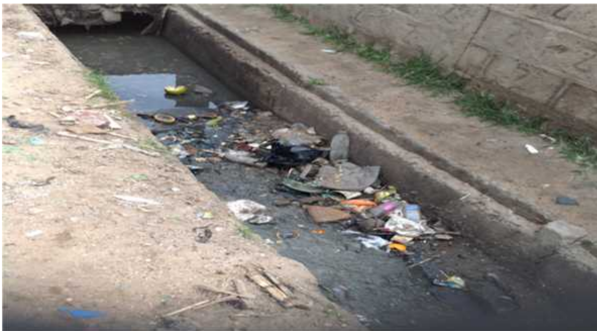
Figura 7: Vala de drenagem de águas pluviais, bairro Maxaquene A
