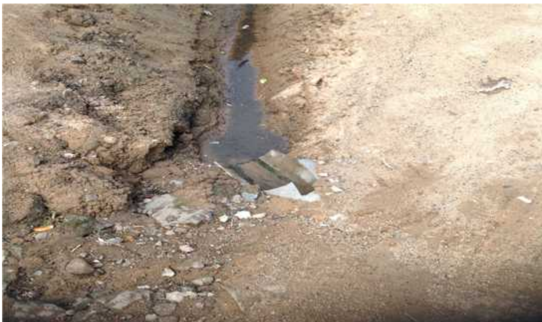
Figura 8: Canalização de águas residuais domésticas para a rua. Bairro Maxaquene B
