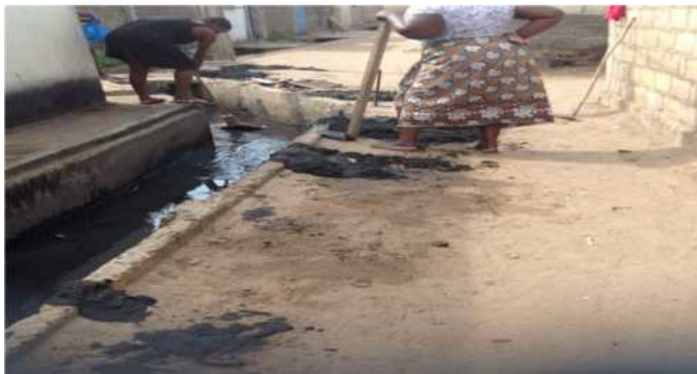
Figura 10 Moradores do bairro Maxaquene fazendo limpezas na vala de drenagem.
