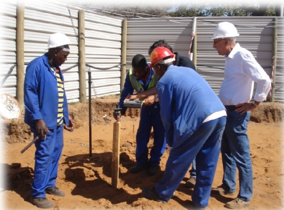
Fig.23-Marcação da obra -topógrafos
