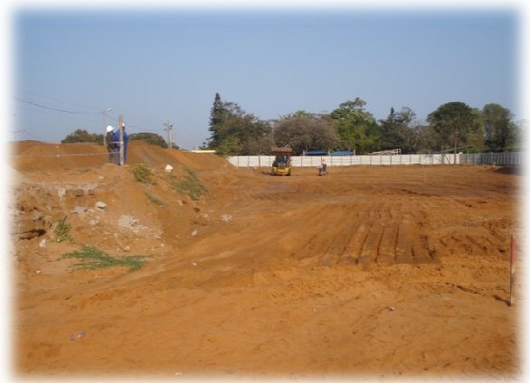
Fig.22-Escavação a 50cm da área a implantar
