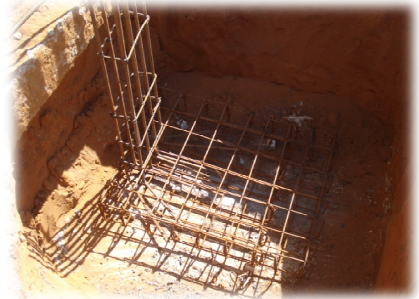
Fig.31- Sapatas e arranque de pilar (sap. centrada) Fig. 32-Bloquetes em sapatas (sap. excêntrica)
