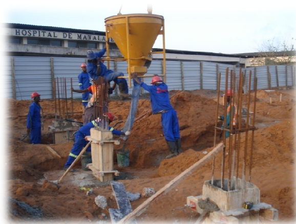
Fig. 33-Ilustra arranque de pilares cofrados em madeira e respectiva betonagem
