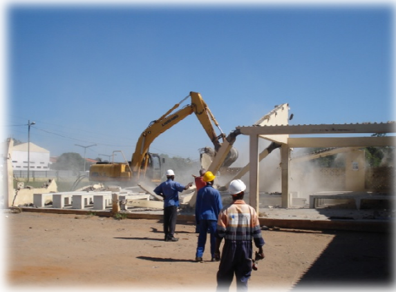
Fig. 19- Demolição do alpendre/banco de socorro
