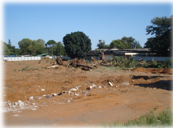
Fig.21-Remoção da camada vegetal
