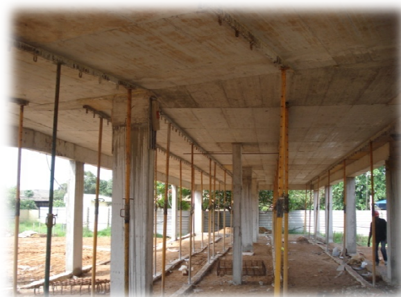
Fig.36-Descofragem parcial em laje
