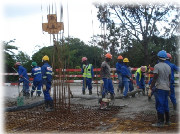
Fig. 38 - Betonagem em laje
