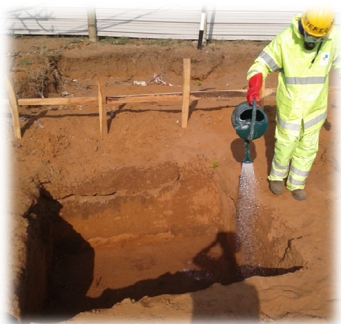
Fig.29-Aplicação de anti-térmita (sapatas)
