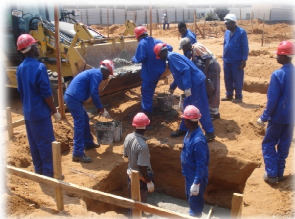
Fig.30-Ilustra a colocação de betão de limpeza
