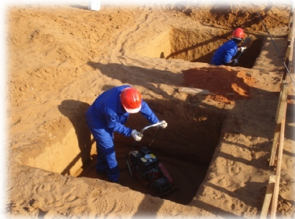
Fig.27-Compactação "Placa vibradora"
