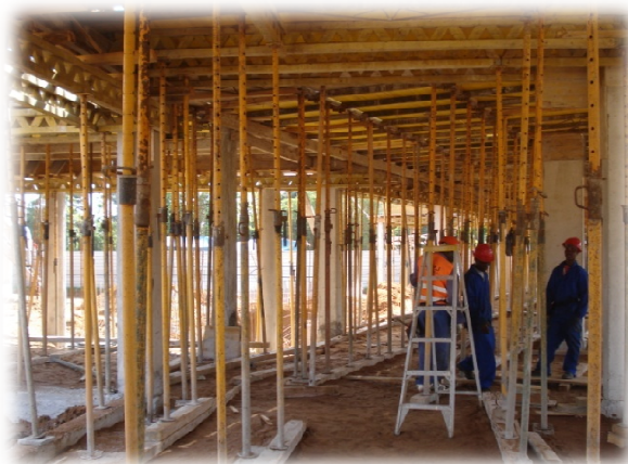
Fig. 35-cofragens em lajes
