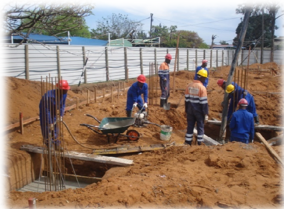
Fig. 37 - Betonagem e vibração em sapatas
