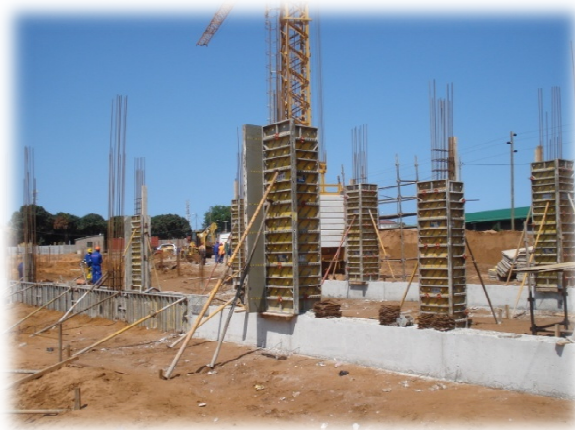
Fig. 34-Ilustra cofragem metálicas em vigas, pilares e parte da viga betonada
