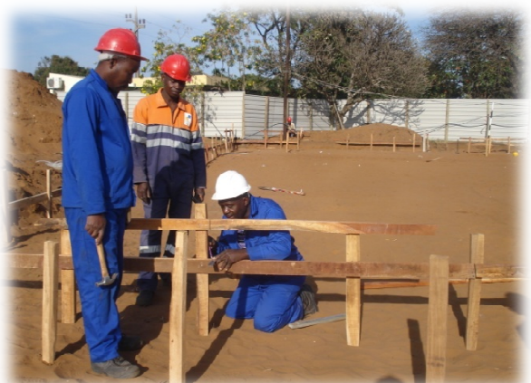
Fig.24- Construção de cangalhos
