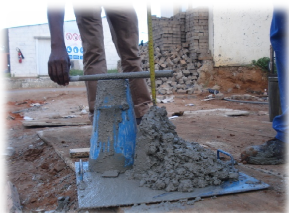
Fig.41 – Abaixamento de cone slump test Resultado obtido (100mm)
