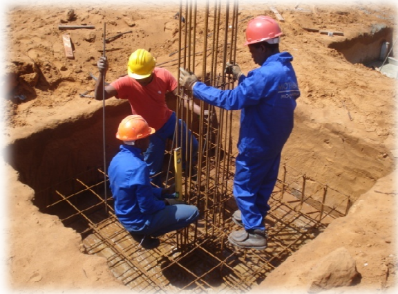
Fig.31- Sapatas e arranque de pilar (sap. centrada) Fig. 32-Bloquetes em sapatas (sap. excêntrica)
