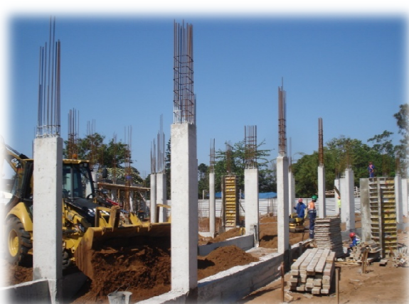
Fig.42 - Compactação de caixas de pavimento
