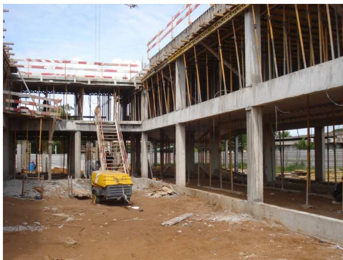
Fig.47 -Ilustra o projecto de estrutura semi-terminado do HGM
