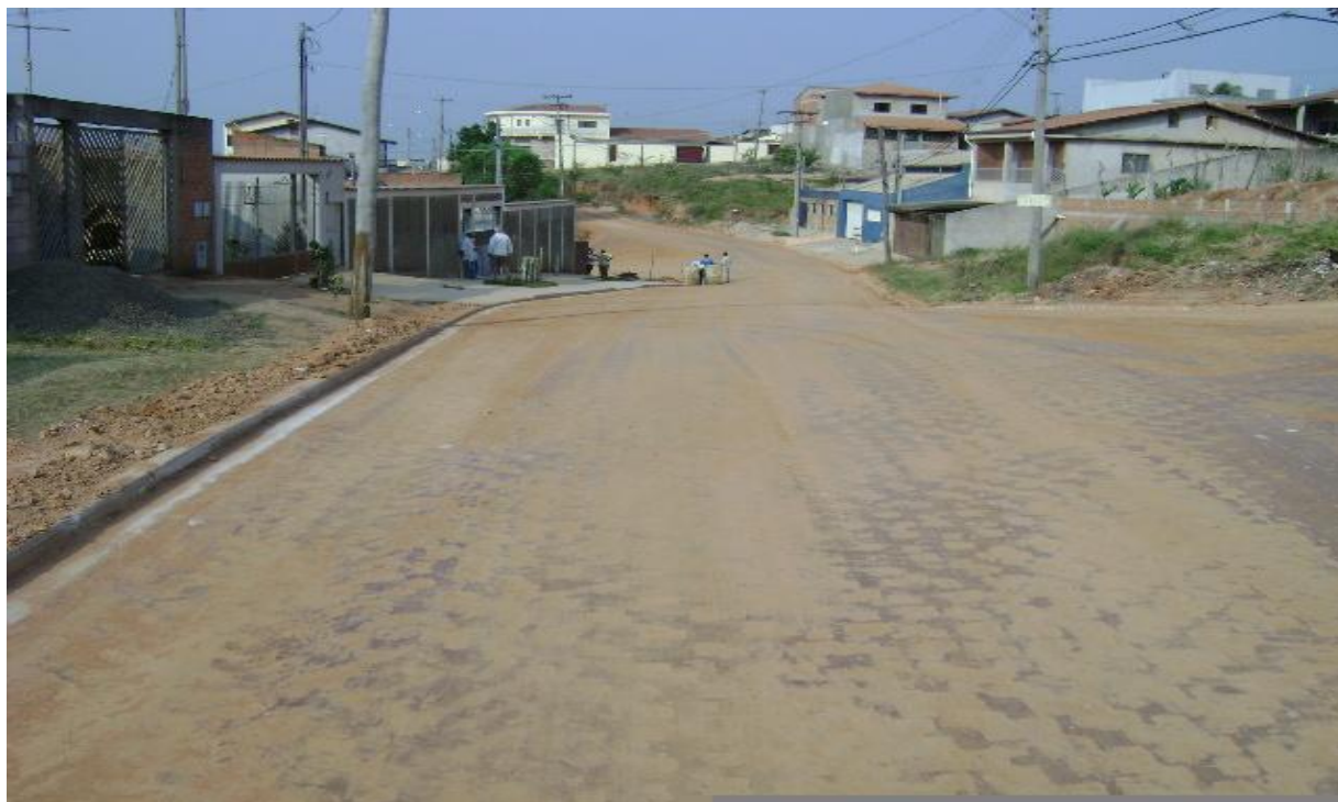
Figura 8 – Pavimento estabilizado com aditivo HomysoloGb em tempo seco Fonte: ROESSLER, 2016, Manual de laboratório IQSCTC
