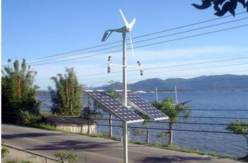
Figura 11: Sistema híbrido eólico fotovoltaico.
