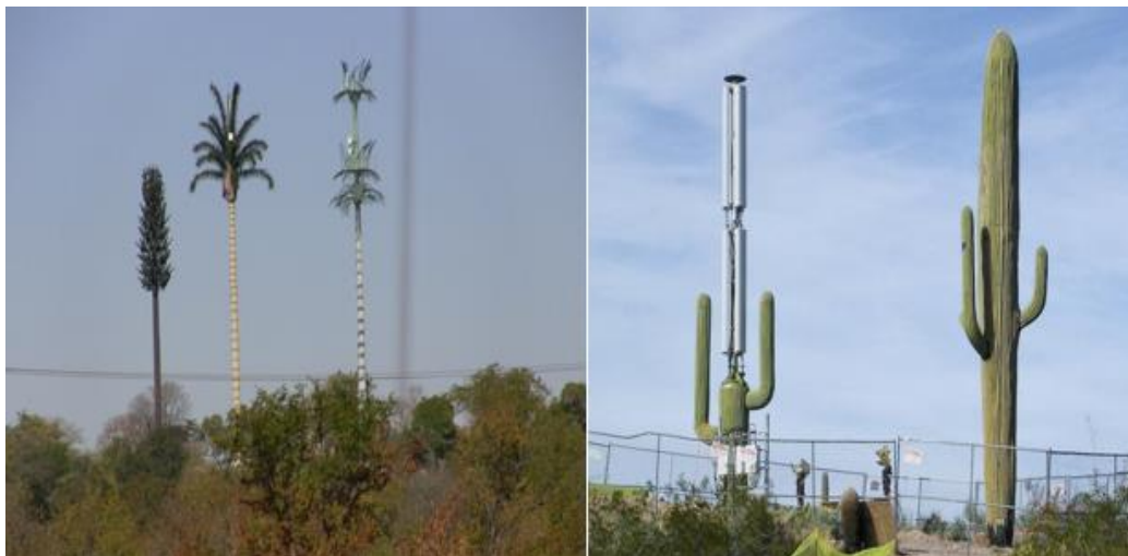
Figura 21: Antenas disfarçadas 4G LTE instaladas nos EUA e Brasil
