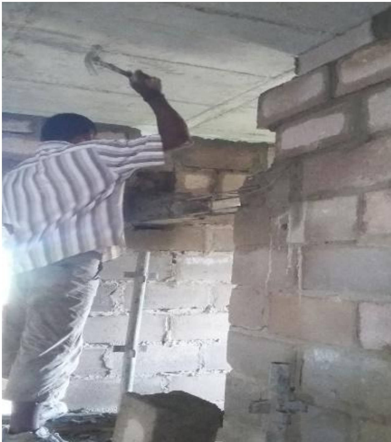
Figura.27. Demolição de um lintel na entrada de um quarto.
