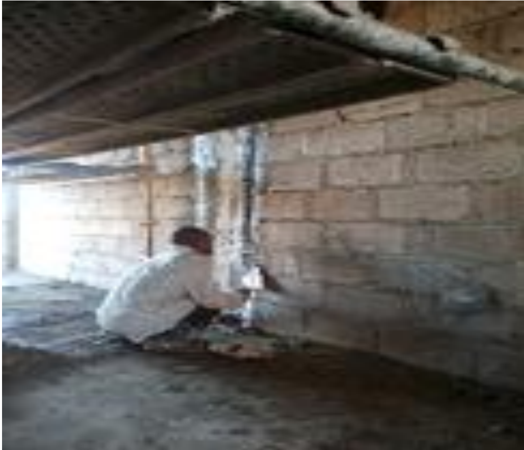
Figura.28. Colocação da rede de fibra na união entre pilares e vigas com as alvenarias.
