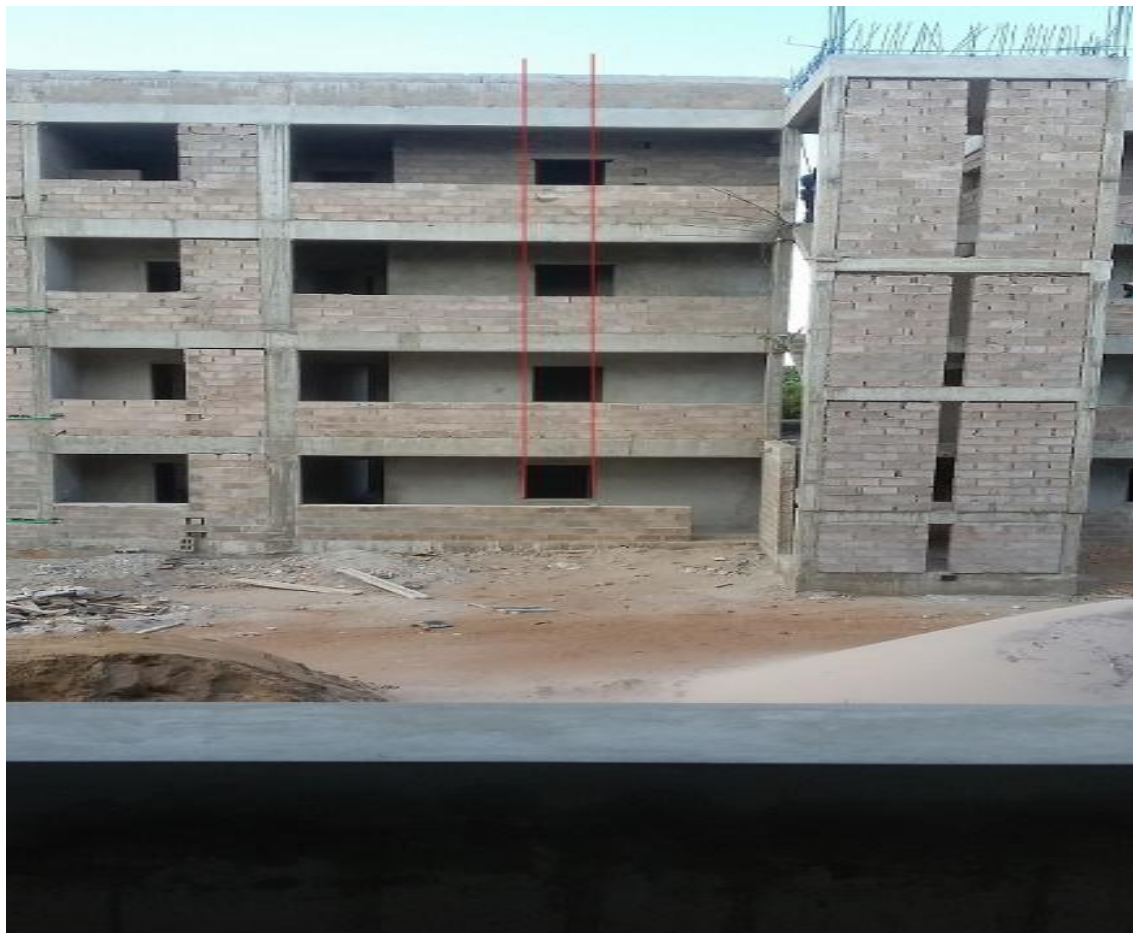
Figura.34. Correção dos prumos de janelas.
