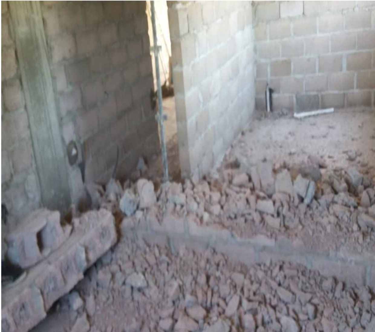
Figura.26. Demolição e reconstrução da parede divisória.
