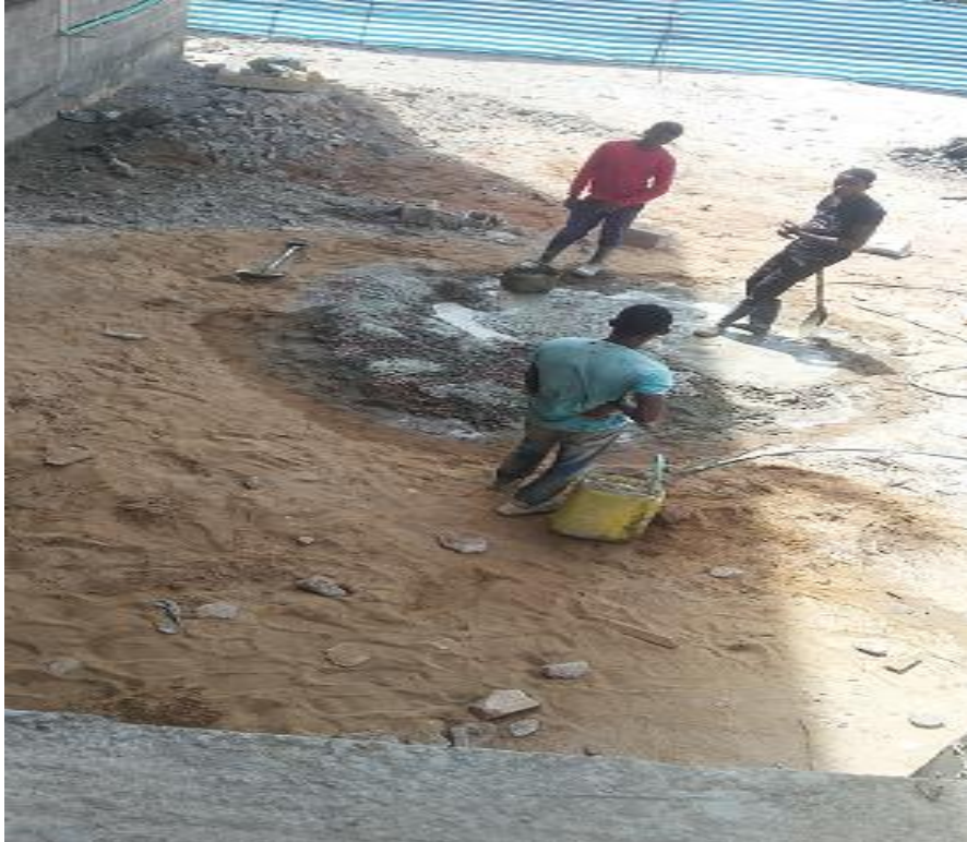
Figura.33. Confeção Manual do betão.
