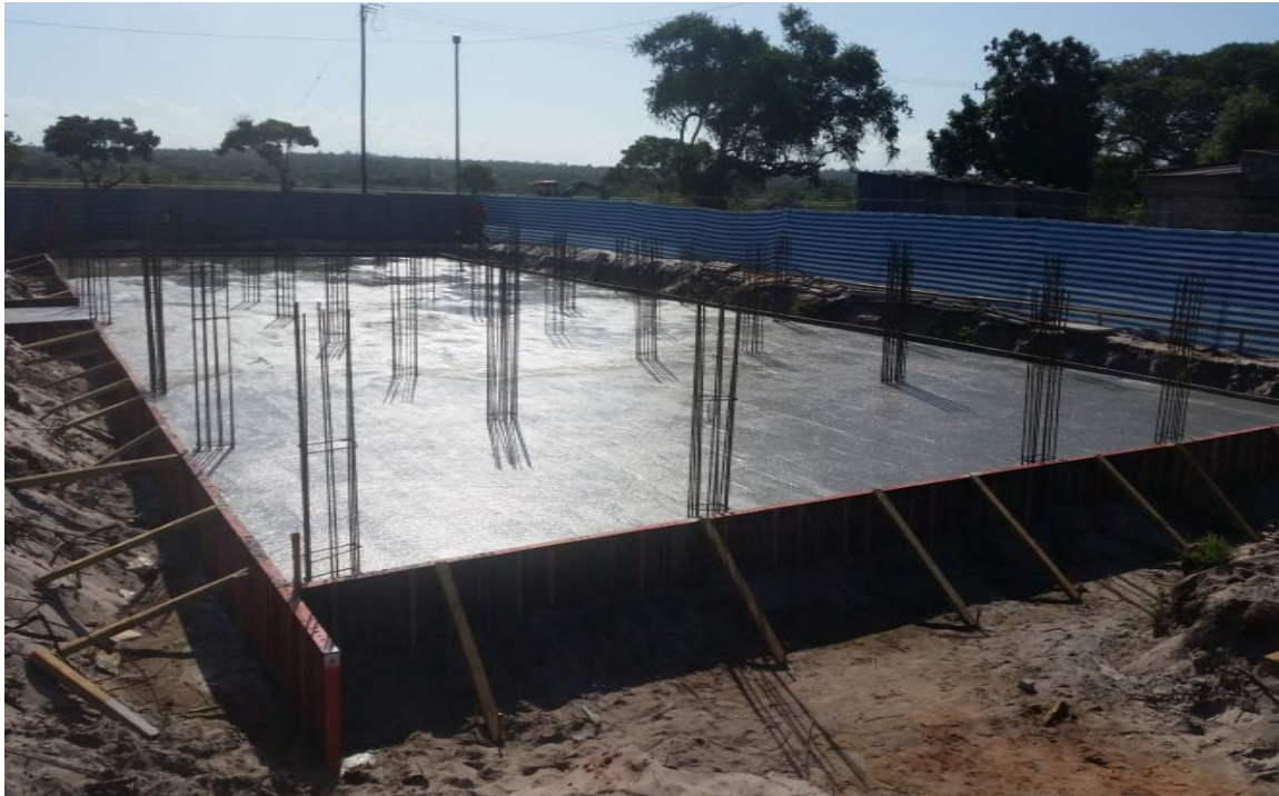
Figura.9. Fundações em ensoleiramento geral.
