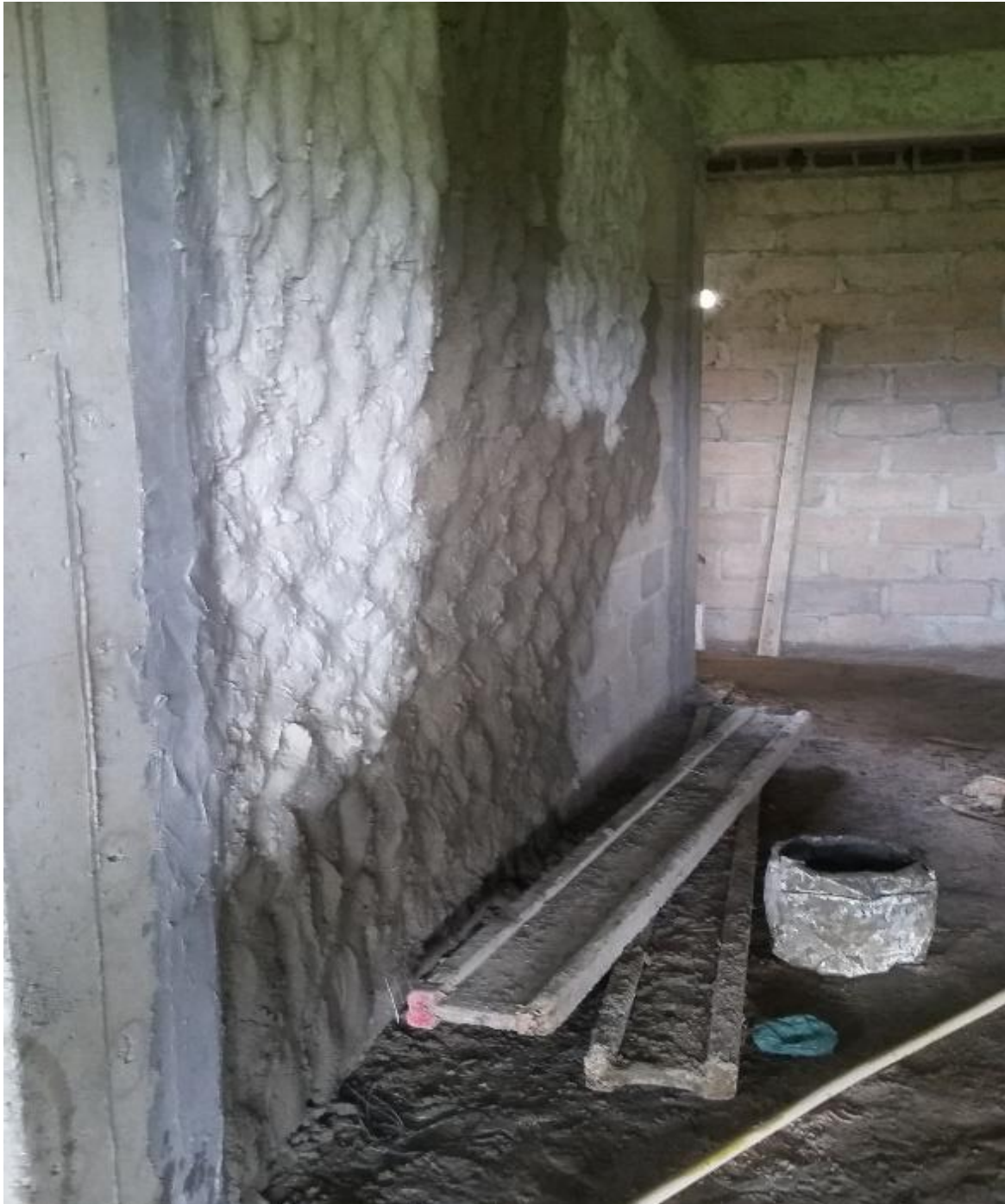
Figura.29. Aumento da espessura da parede.
