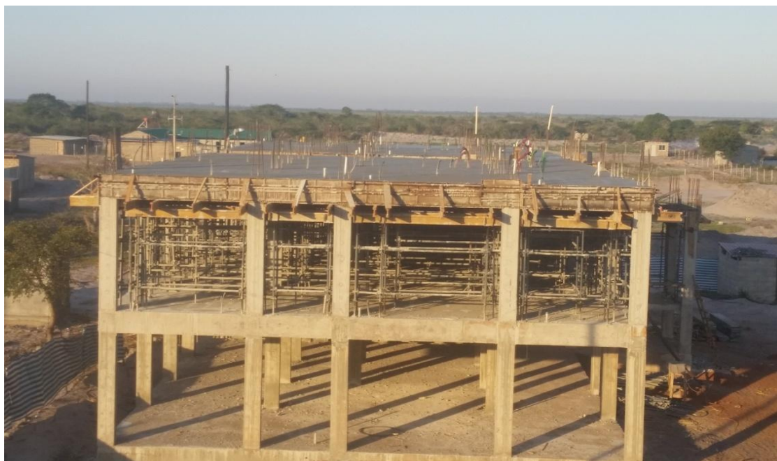
Figura.11. Execução da laje maciça.
