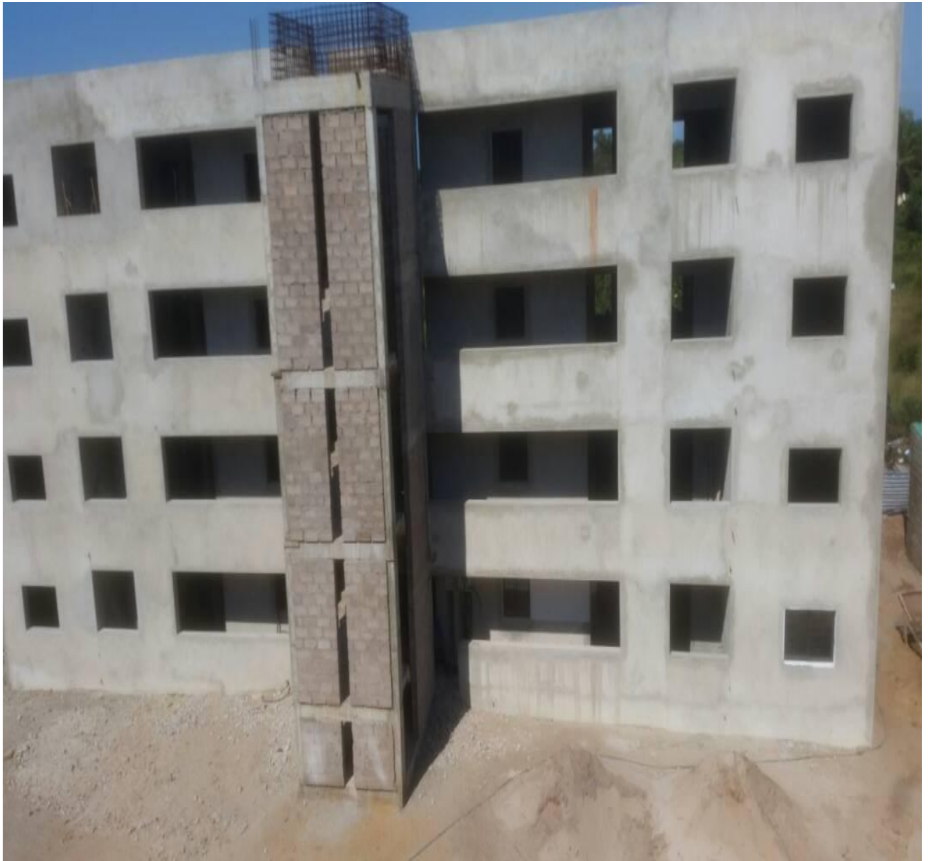
Figura.38. Estrutura final rebocado interna e externa.
