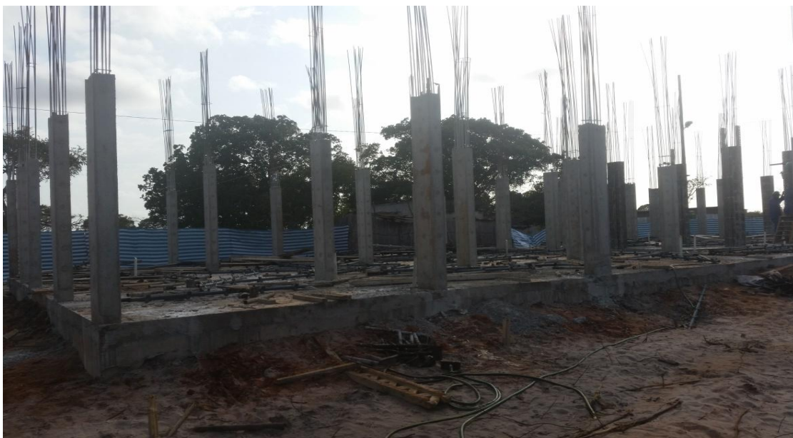
Figura.10. Muros em alvenaria e pilares em betão armado.
