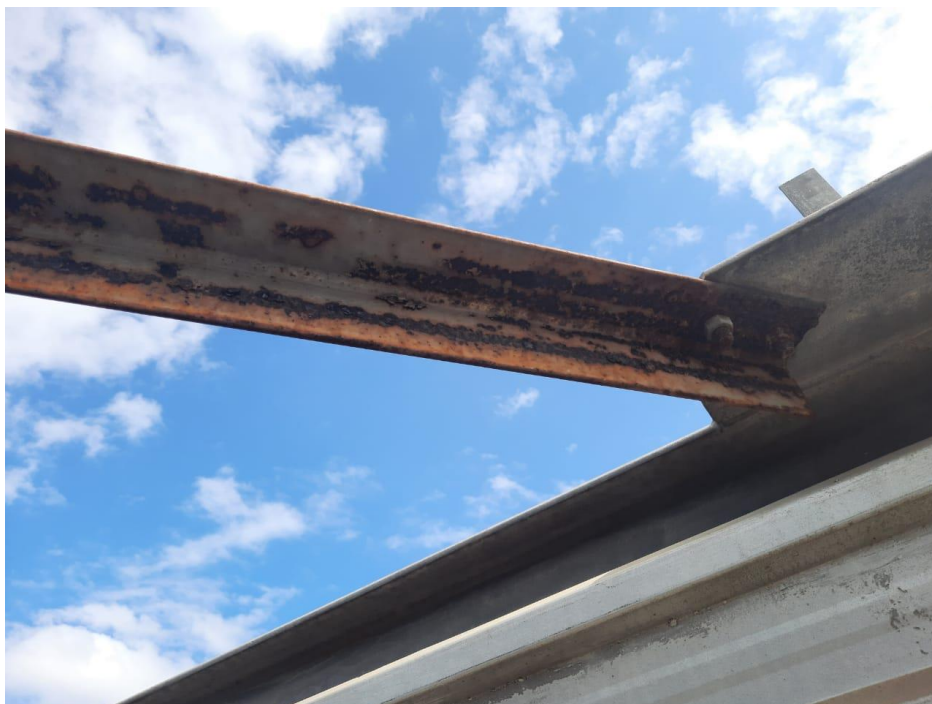
Figura 2. Cantoneira de sustentação da cobertura.
