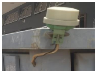
Figura 5: fotocélula usada na Iluminação Publica
