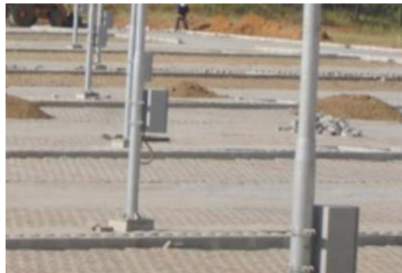
Figura 19. Fixação do gabinete no poste. Fonte: SunLab (2018)
