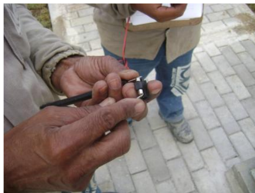
Figura 22. Verificação dos fusíveis de proteção. Fonte: SunLab (2018)
