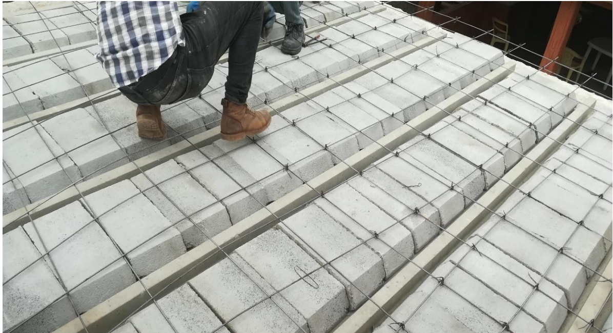
Figura 31: Colocação das Armaduras
