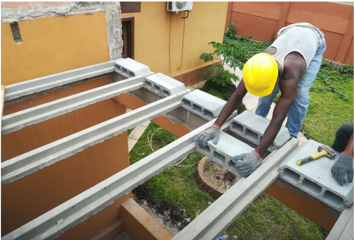
Figura 29: Colocação de Vigotas
