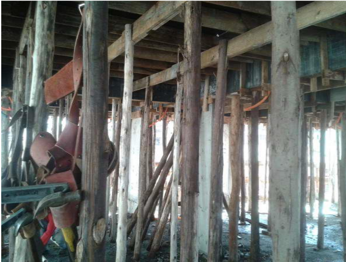
Figura 13: Colocação dos prumos
