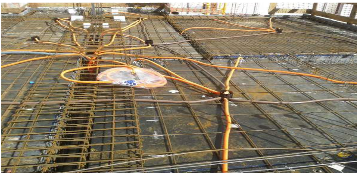
Figura 15: Electrodutos e caixas de passagem na cofragem de laje maciça
