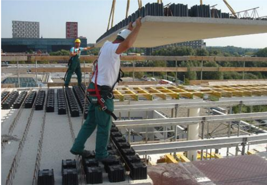
Figura 27: Solução de aligeiramento - Sistema AirDeck
