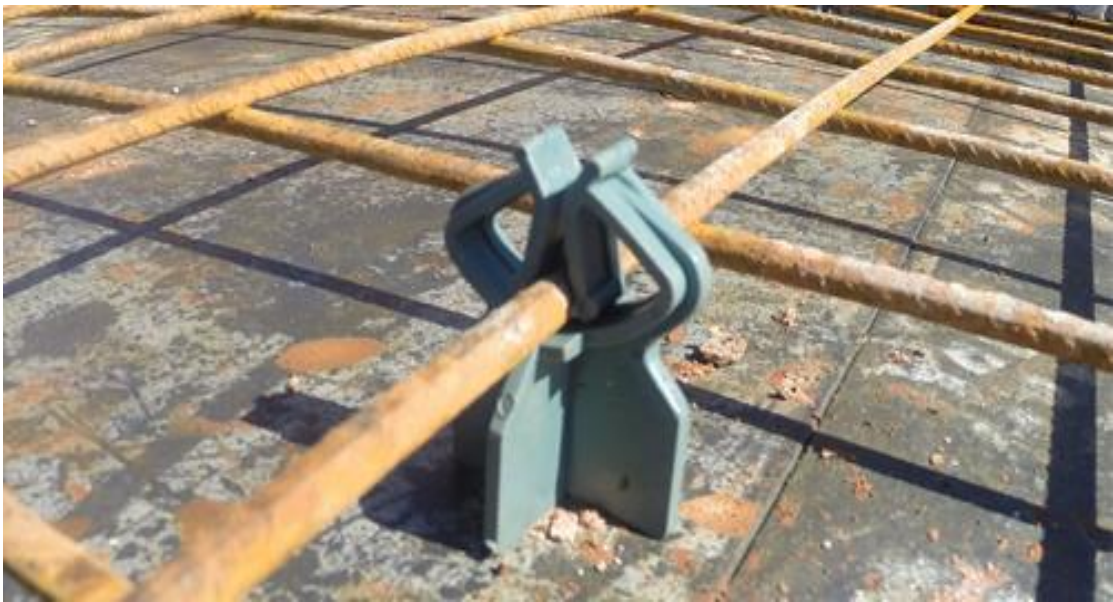
Figura 14: Espaçadores de armaduras
