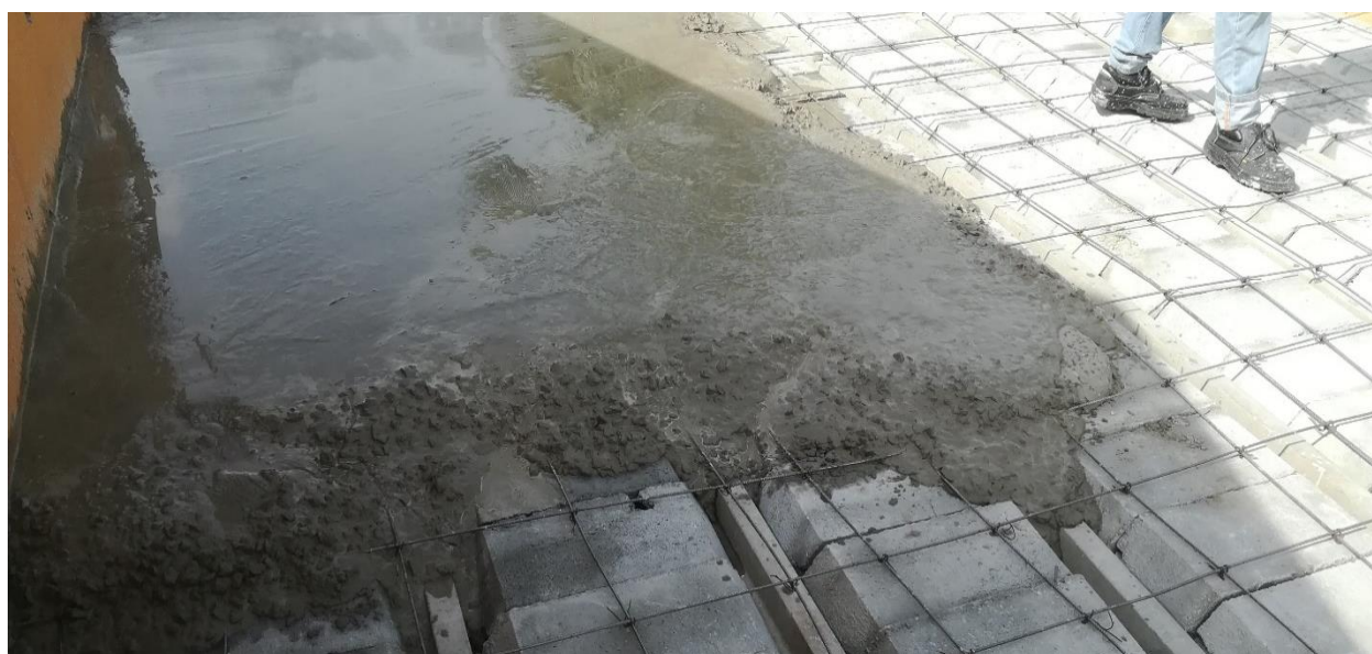
Figura 20: Betonagem das nervuras
