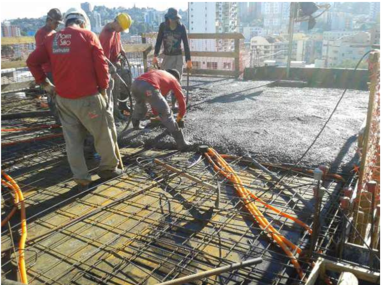
Figura 16: Lançamento e regularização do betão
