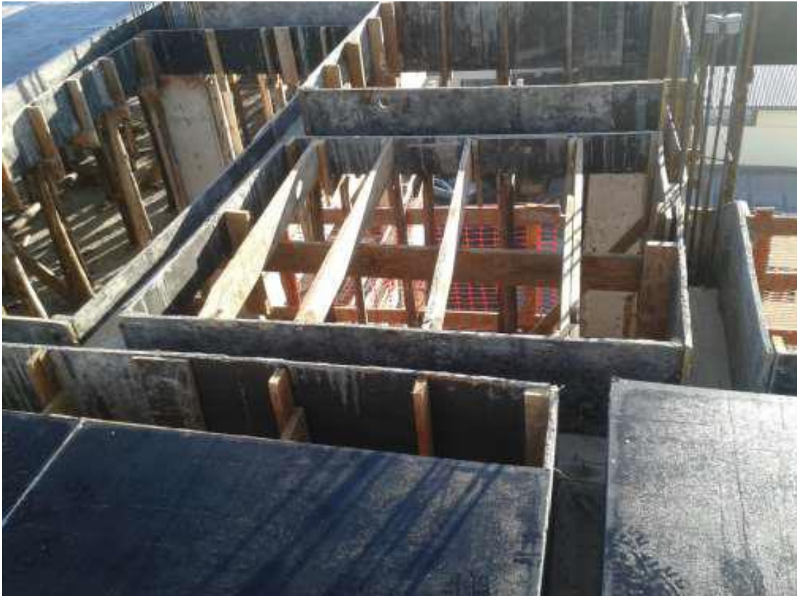
Figura 12: Cofragem de Laje Maciça, com prumos longarinas e travessas aparentes
