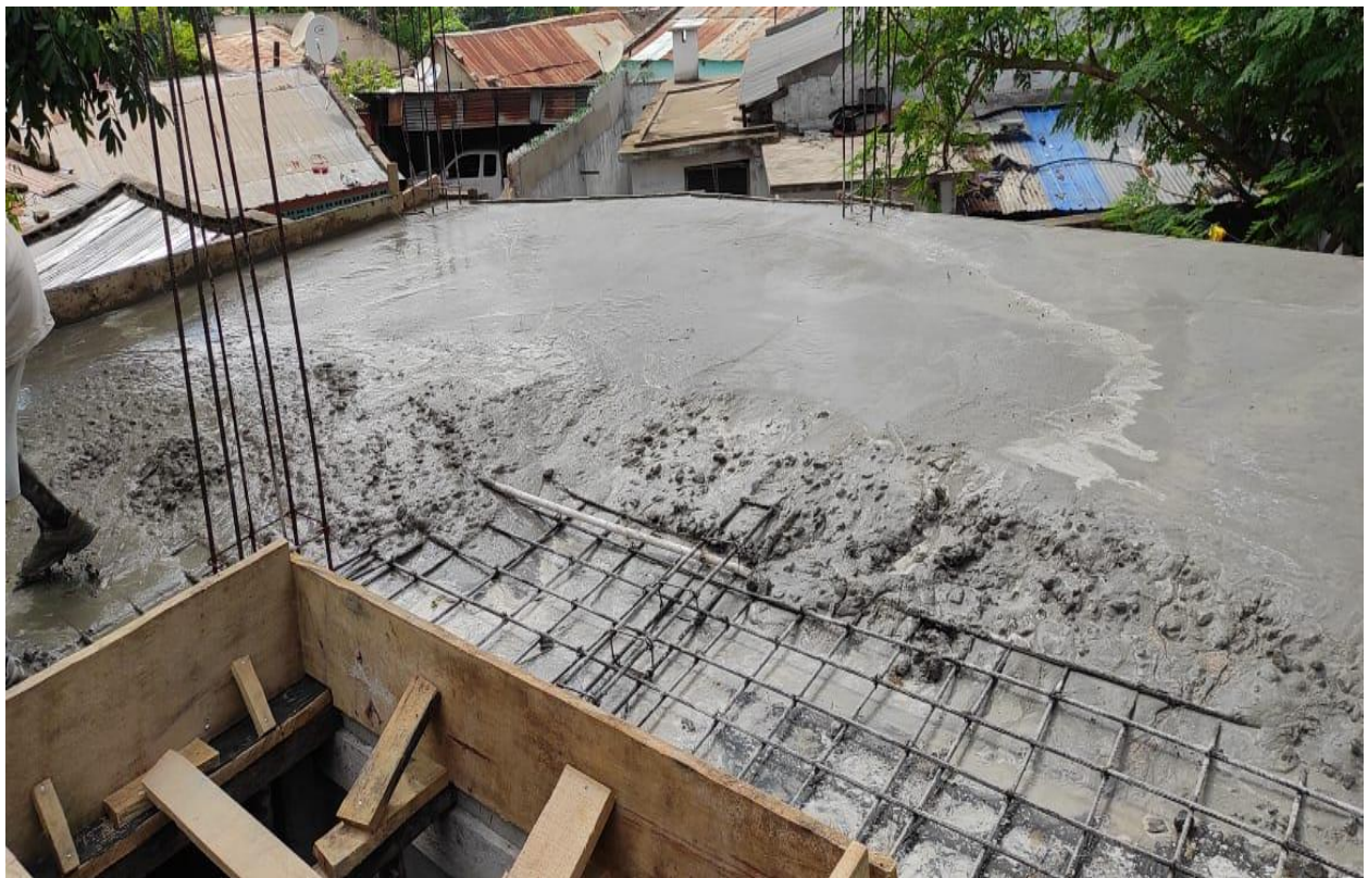
Figura 10: Betonagem de uma laje maciça
