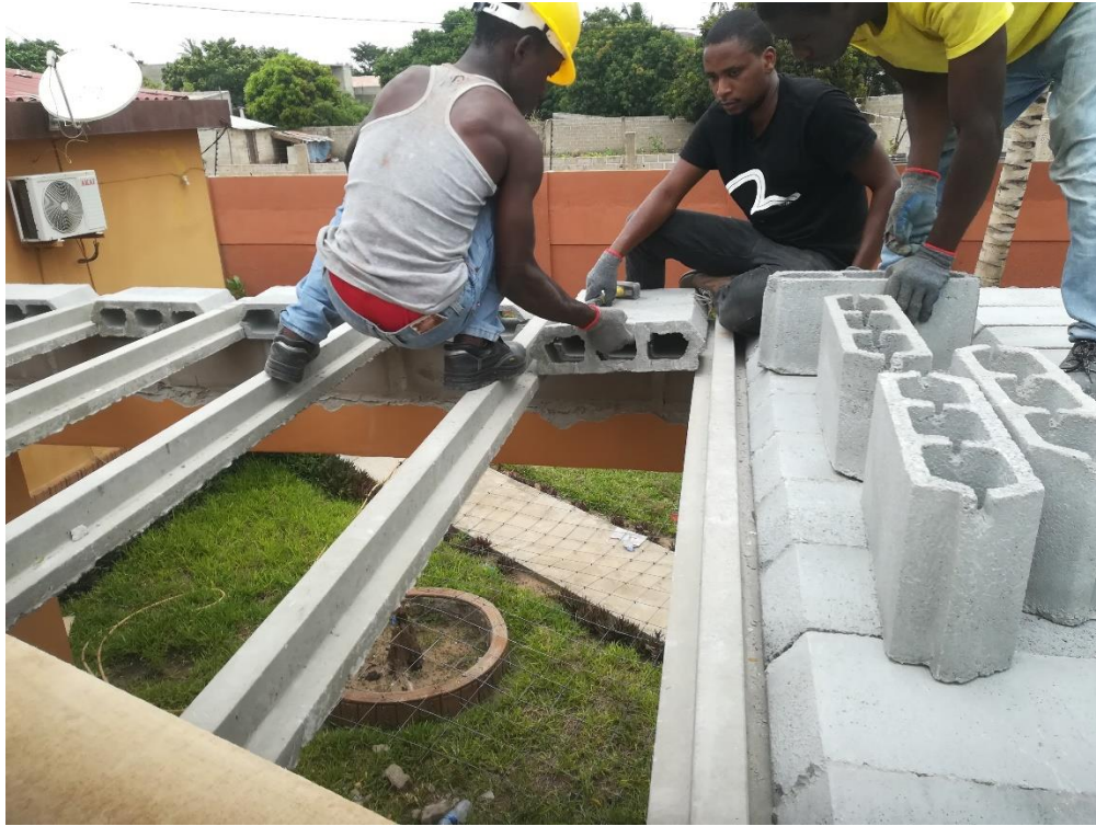
Figura 30: Colocação das Abobadilhas
