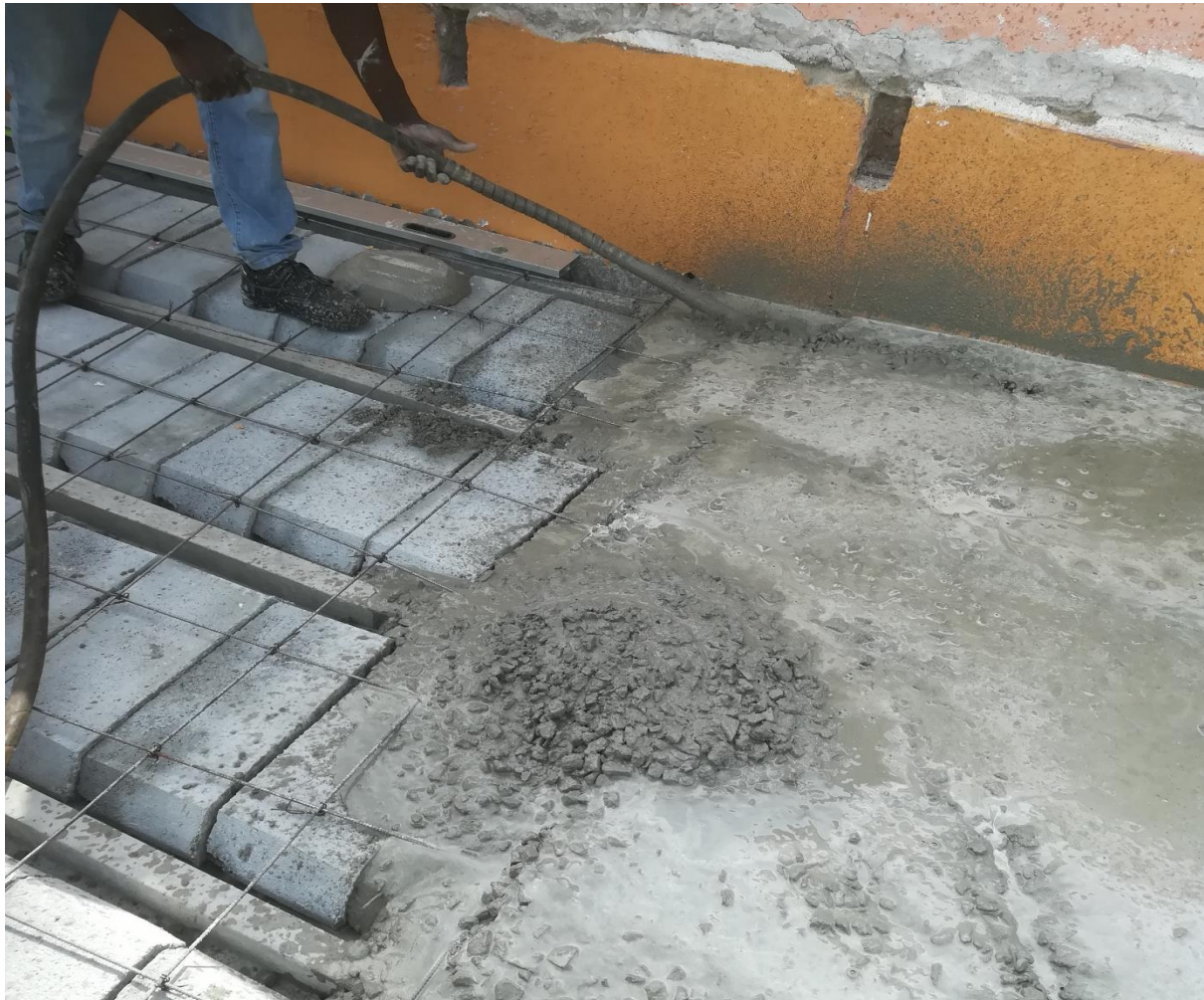
Figura 33: Lancamento e vibração do Betão
