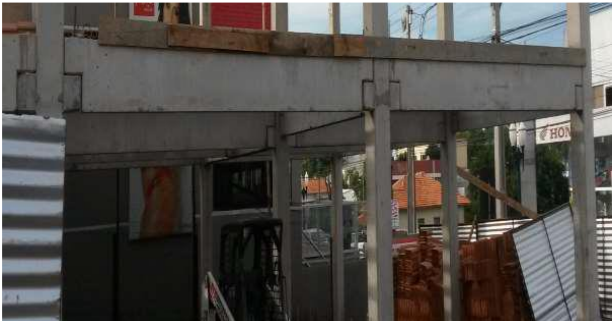
Figura 32: Instalação de guias
