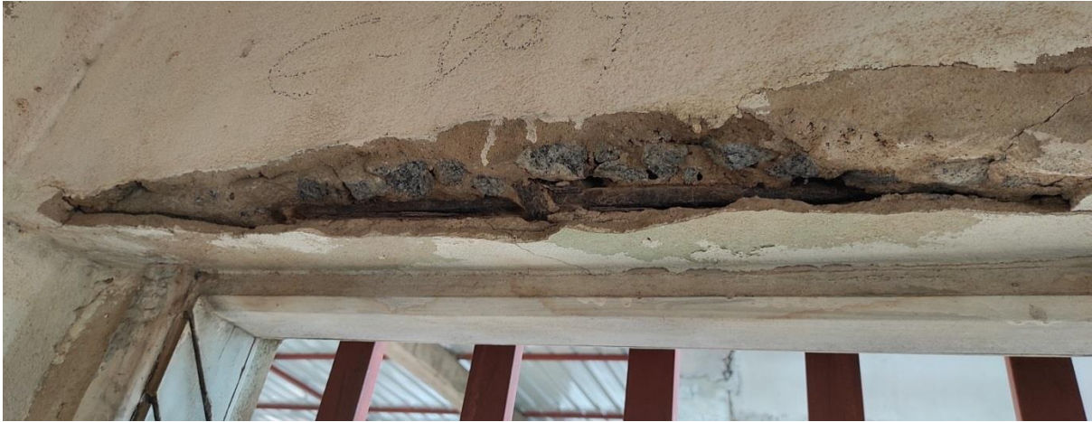
Figura 33:Exposição das Armaduras dos Lintéis
