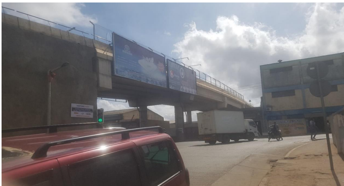
Figura 14:Viaduto da cidade de Nampula
