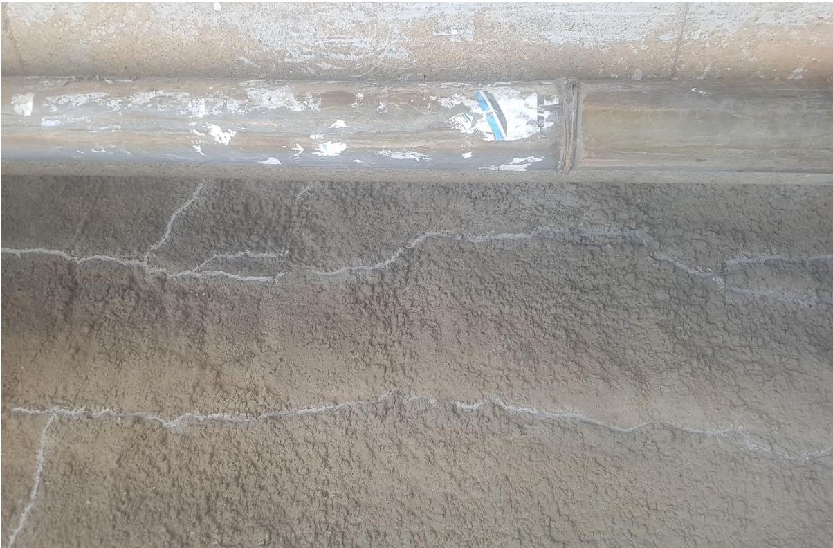
Figura 17: Fissuras do viaduto da cidade de Nampula
