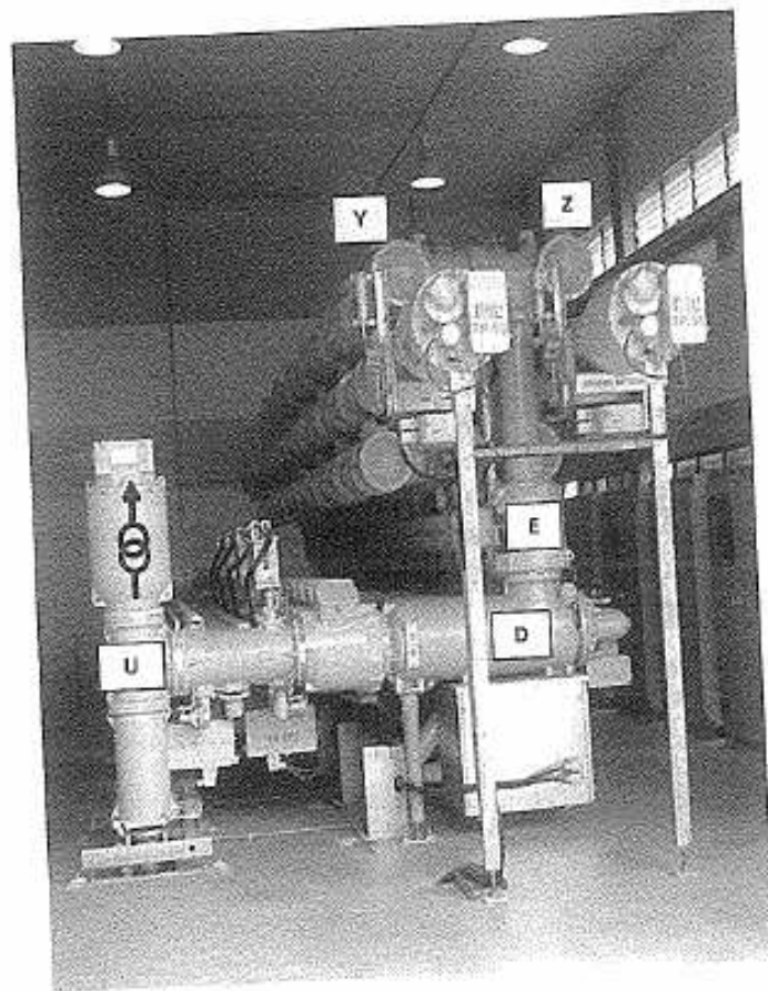
Figura 14.11a – Compartimentação da célula de uma LTS.
