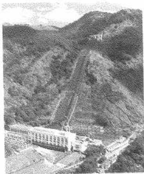
Figura 19.4 – Tubulação forçada da Usina Hidrelétrica de Fontes.
