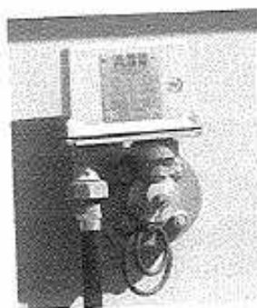
Figura 11.2 - Relé de pressão para proteção do CACC.
