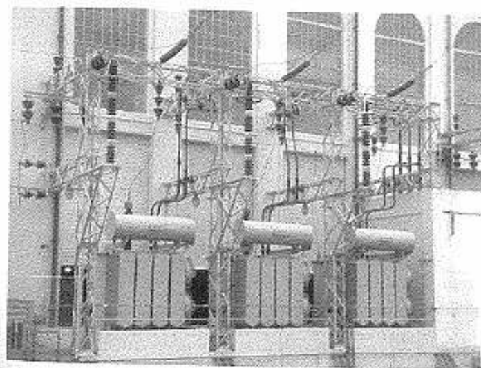
Figura 19.10 – Subestação elevadora.
