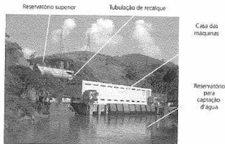
Figura 19.21 – Usina elevatória de Vigário.
