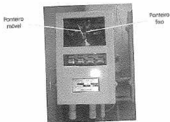
Figura 10.10 – Indicador de temperatura do enrolamento.
