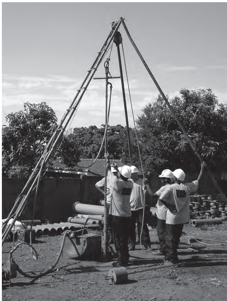
Trabalho de investigação do subsolo Fonte: fôlder da IBVP Engenharia (2010).
