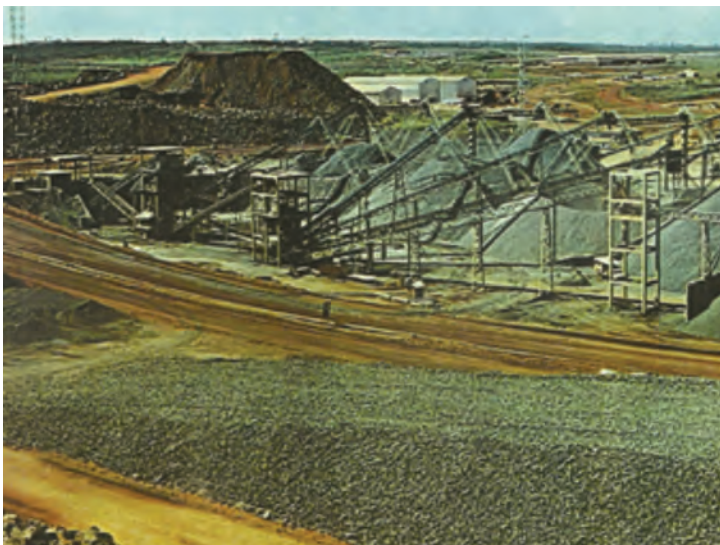
FIG. 4.3 Um avançado sistema de britadores primários, secundários e terciários constituiu as instalações de britagem do canteiro Fonte: Revista Engenharia (1973).
