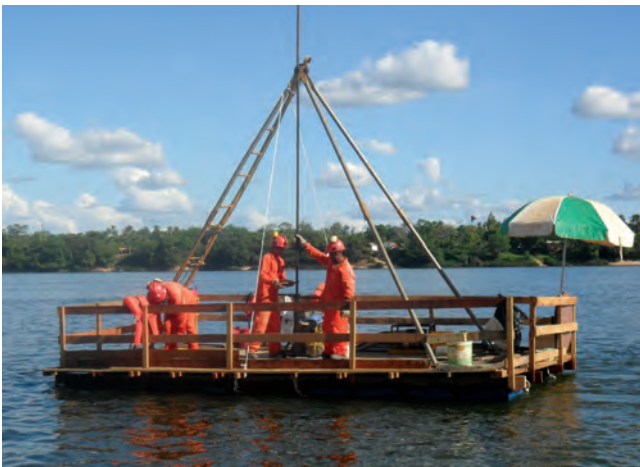
FIG. 7.17 Sondagem rotativa em balsa no rio Paraíba (SP)
