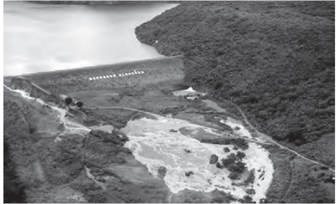
FIG. 13.34 Rompimento da barragem de Algodões (PI)
