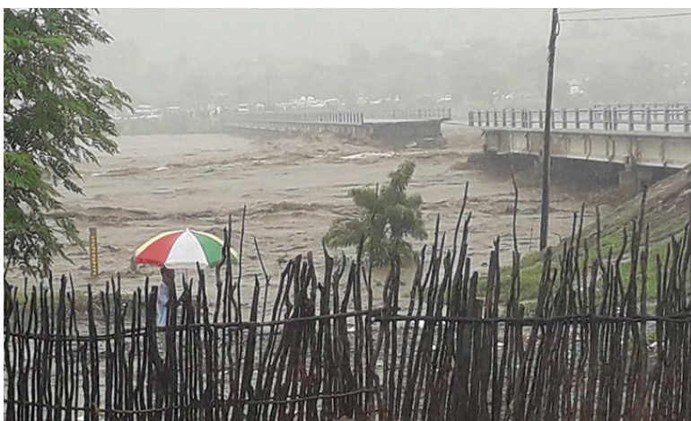
Figura 2: Ponte destruída pela tempestade Ana (Fonte: Dgedge (2022))
