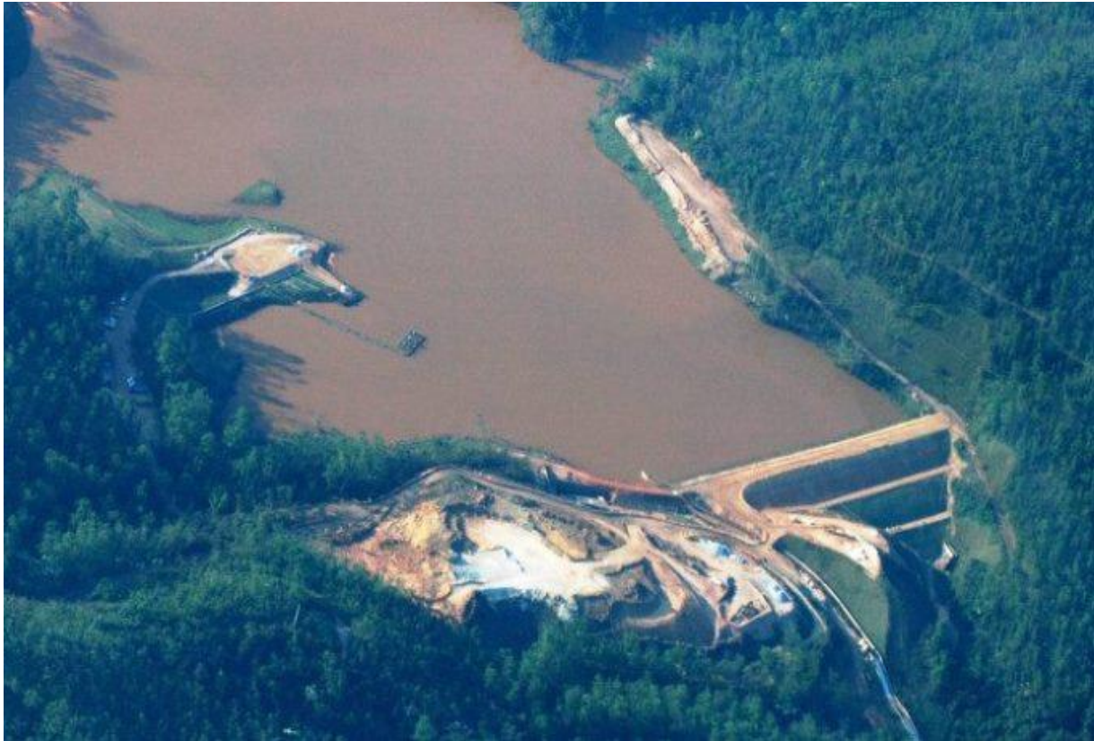
Figura 2- Barragem de rejeitos e o desastre em Mariana – MG:
