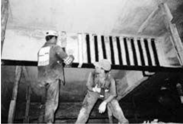
Fotografia 1. – Reforço de viga de betão à flexão e ao corte (Fonte: Machado, 2010).
