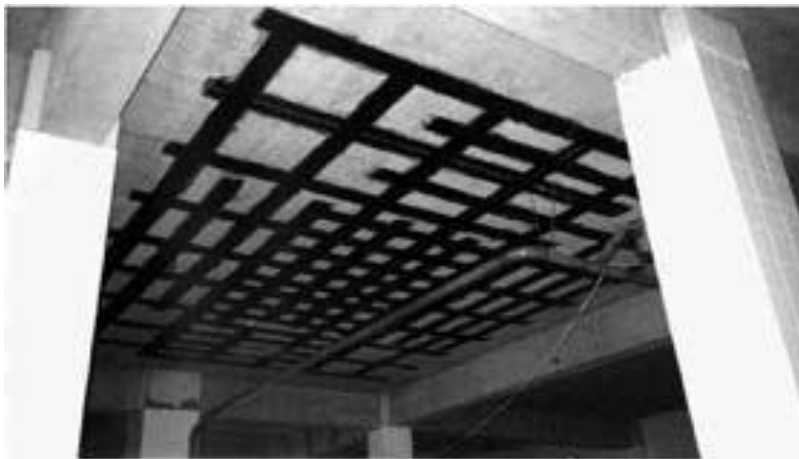
Fotografia 2. – Reforço de lajes à flexão nas duas direções (Fonte: Machado, 2010).
