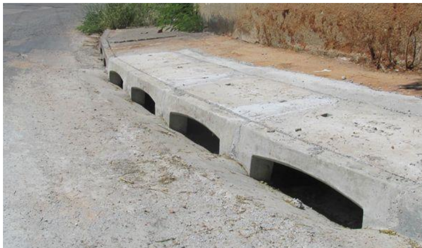
Figura 09: Boca de Lobo Simple
