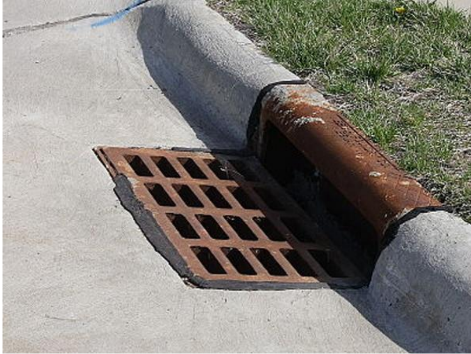
Figura 11: Boca de Lobo Combinada
