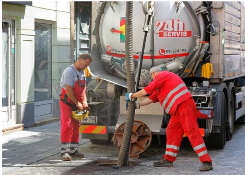
Figura 18: Camiões de mangueira de pressão
