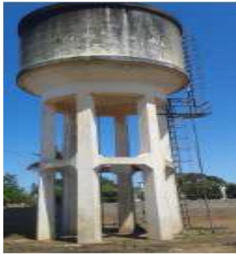
Figura 17: deposito 215m 3 ; fonte autor
