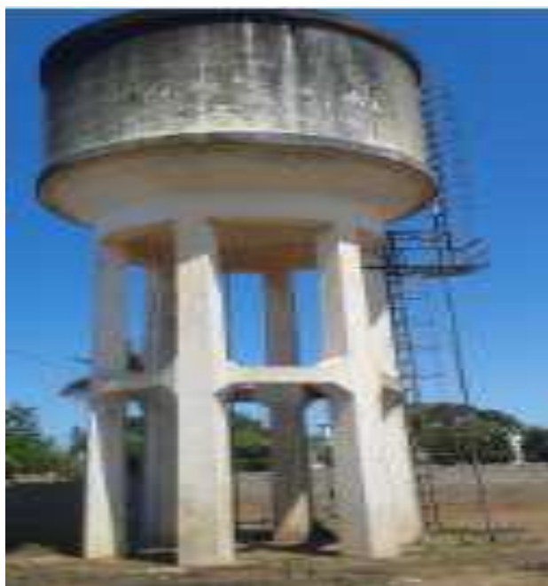
Figura 10: Deposito elevado de 215m 3 dentro da Vila: FONTE autor
