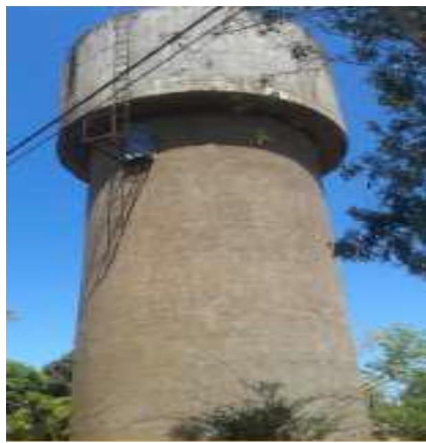
Firua 11: Deposito elevado de 250m 3 do Bairro 29 de Setembro: fonte Autor
