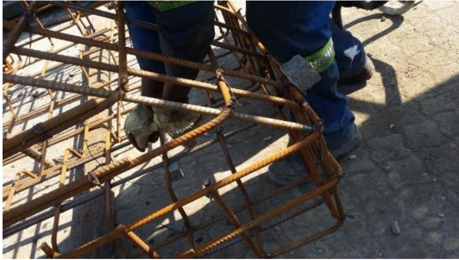
Figura 25 - Colocação de separadores
