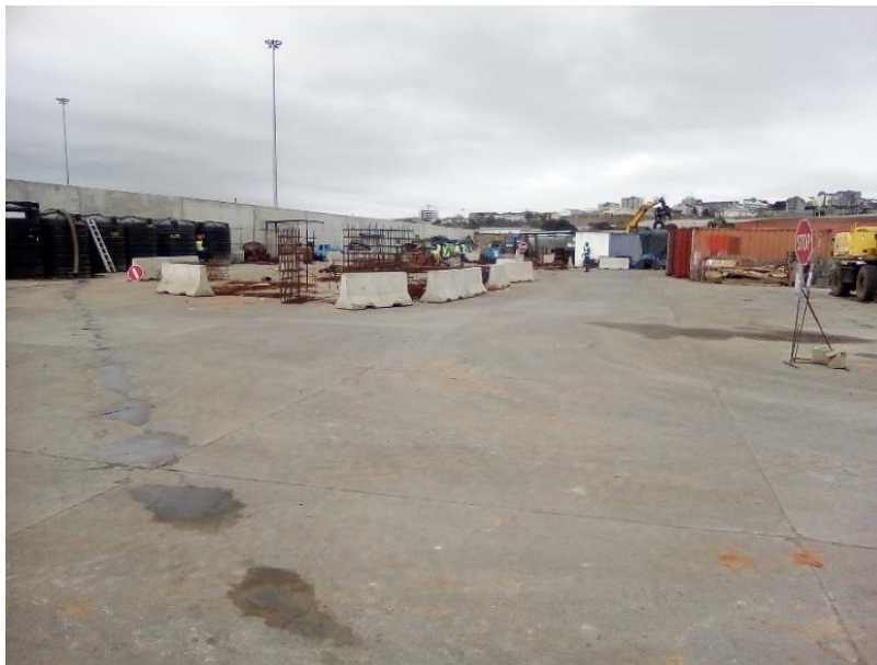
Figura 43 - Jersey Blocks de 0.8m de altura como Limitadores de zonas em Obra Fonte: (10181 – Produção e Fornecimento de Barreiras New Jersey)
