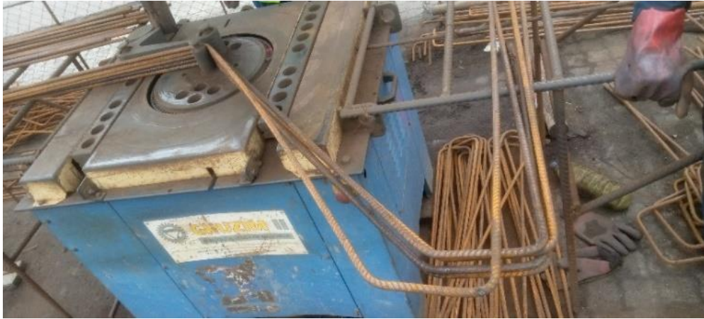
Figura 23 - Dobragem do ferro Fonte: (10181 – Produção e Fornecimento de Barreiras New Jersey)
