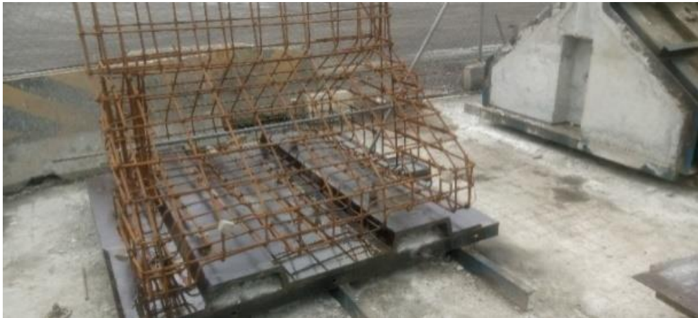
Fig. 26 - Colocação da armadura na base do molde a ser betonado
