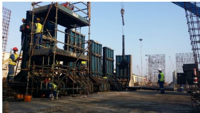
Figura 33 – Descofragem Fonte: (10181 – Produção e Fornecimento de Barreiras New Jersey)
