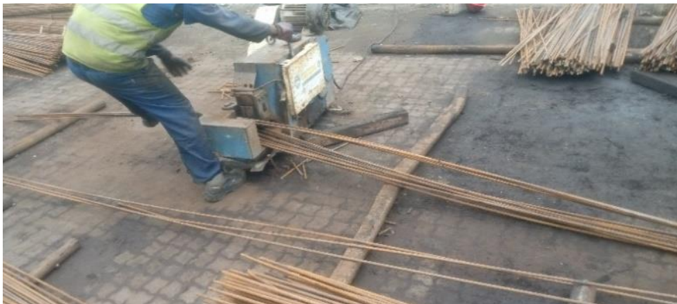
Figura 22 - Corte do ferro
