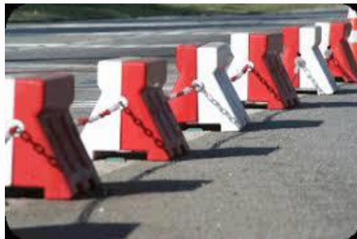
Fig. 2 – Montagem sequencial das barreiras plásticas New Jersey. Fonte: ( http://sinalisa.com.br )
