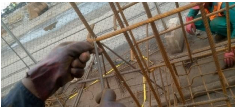
Figura 24 – Amarração Fonte: (10181 – Produção e Fornecimento de Barreiras New Jersey)
