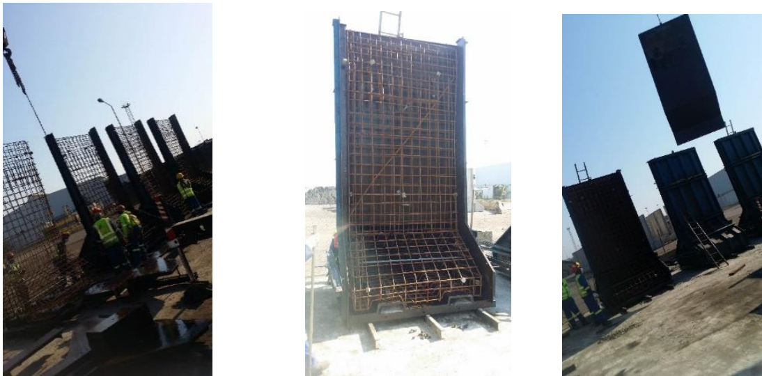
Figuras 27/28/29 - Montagem das cofragens
