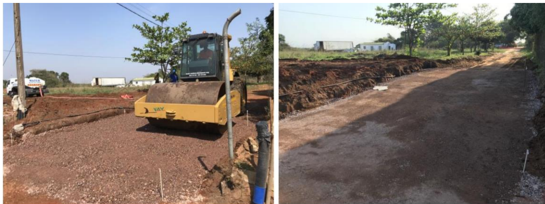
Figura 25- Execução da camada de base em toutvennant.
