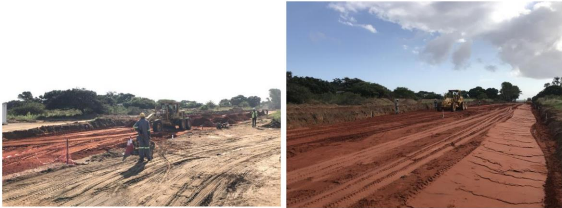
Figura 24 - Aterro e nivelamento da sub-base com saibro
