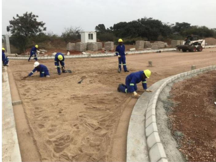
Figura 27- Execução da camada de assentamento de areia grossa.
