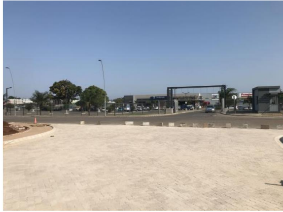
Figura 31- Pavimento de blocos de pavê acabado.
