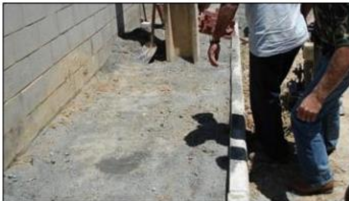
Figura 13- Contenção lateral (Maski, 2013).
