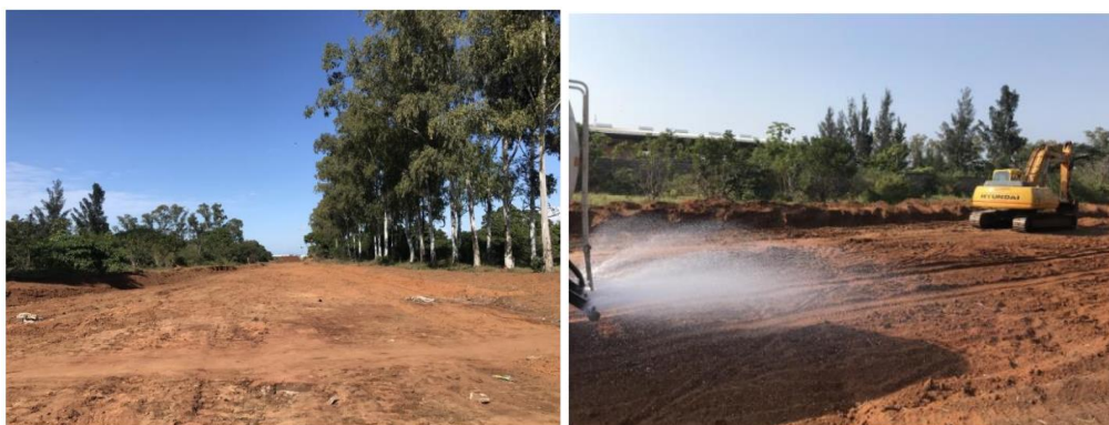
Figura 23- Preparação do fundo de caixa.
