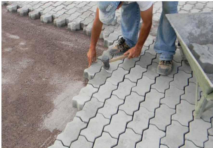
Figura 4- Assentamento manual de blocos de Pavê. (2).
