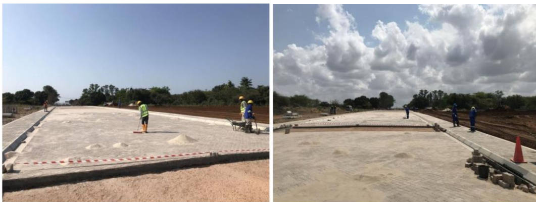
Figura 30- Espalhamento e varrição da areia de rejuntamento
