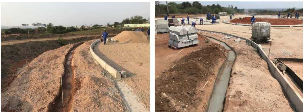
Figura 26- Execução das contenções laterais.
