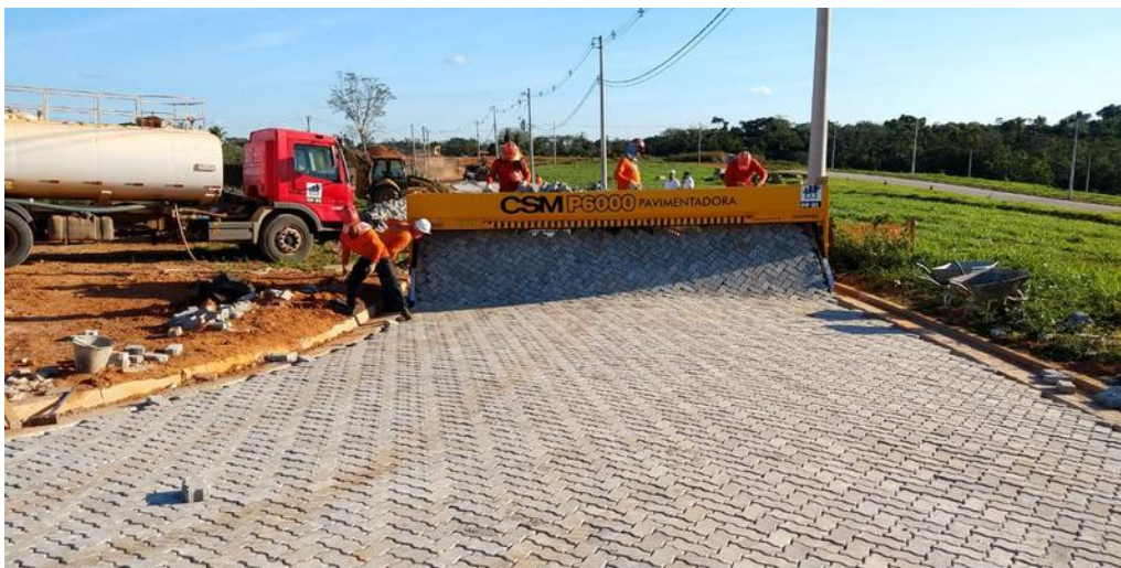
Figura 18- Assentamento mecanizado de Pavês utilizado na Holanda. (4).
