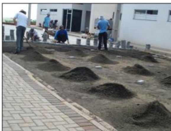
Figura 14- Espalhamento da areia de assentamento (AMADEI, 2011).
