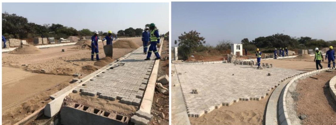
Figura 28- Assentamento dos blocos de pavê.
