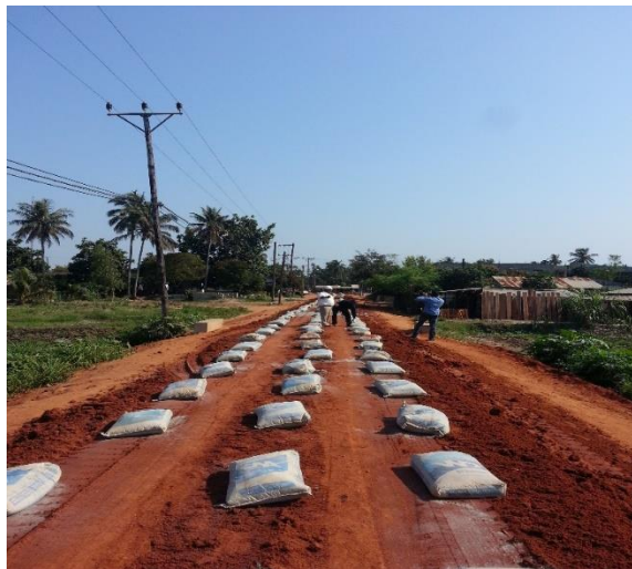
Fig. 11: Enquadramento do Cimento sobre a superfície da estrada.
