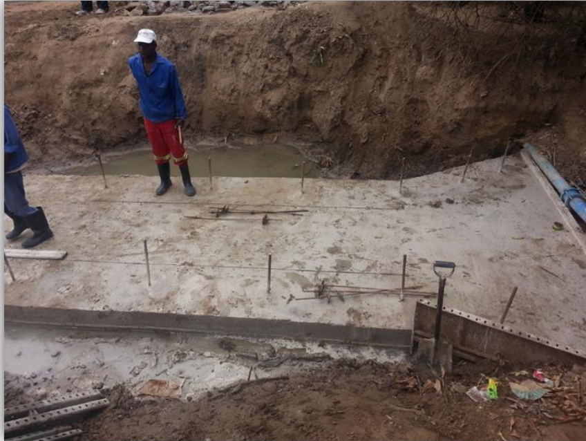
Fig. 7: Abertura e construção da base de Sanjas.
