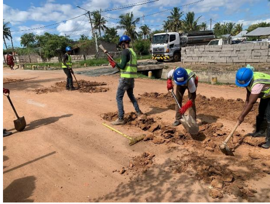
Figura 10: Reparação da Plataforma
