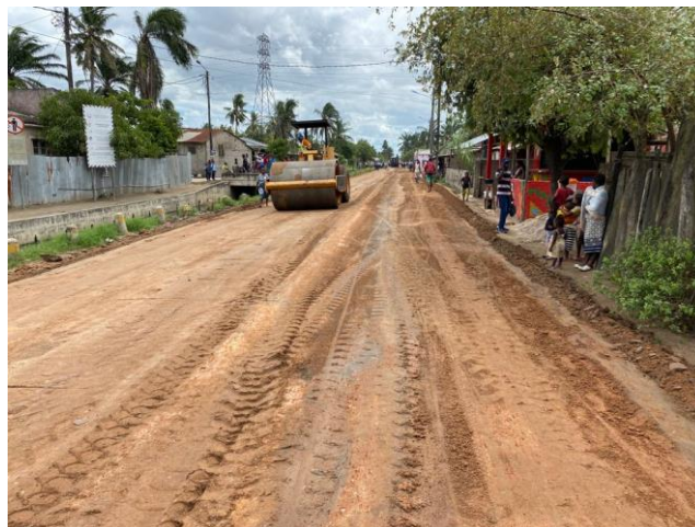
Fig. 9: Nivelamento da estrada.
