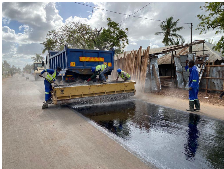
Fig. 13: Espalhamento e Nivelamento da primeira camada de pedra de calco.
