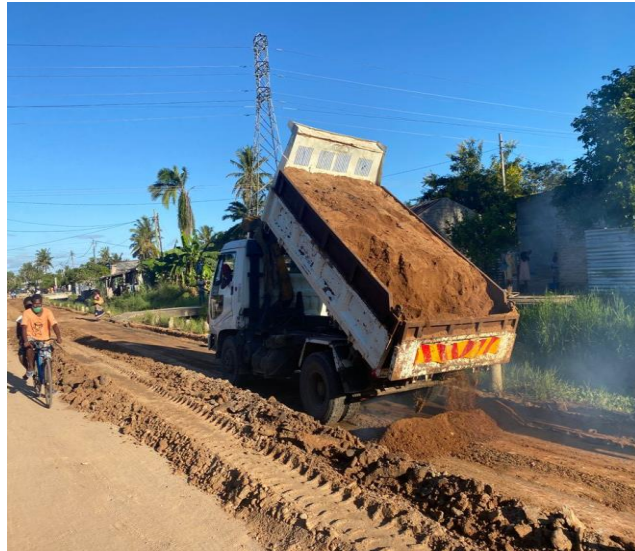
Figura 8: Descarregamento de Solos
