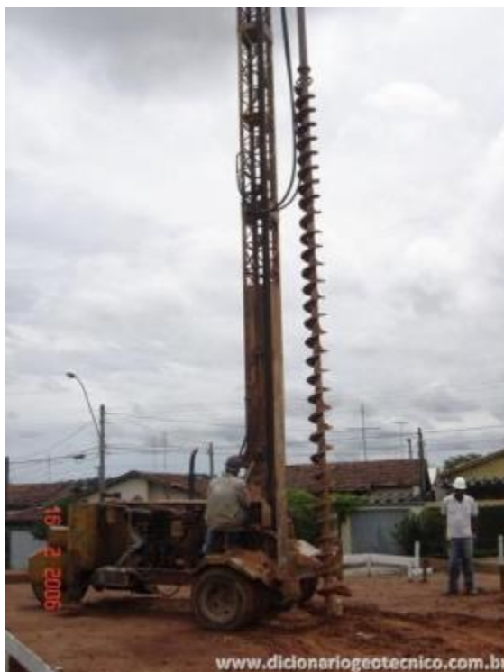
Figura 4- Trado de furação para se introduzir os perfis no terreno [5].
