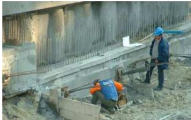
Figura 26- pré-esforço das ancoragens [29].
