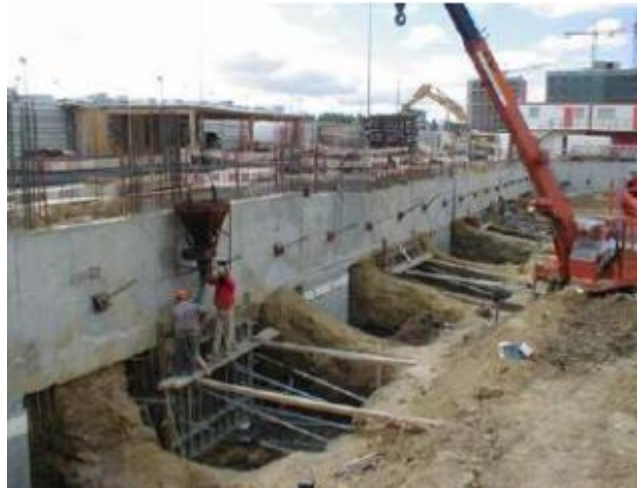
Figura 7- Banquetas entre painéis primários [8].
