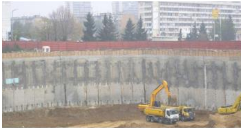
Figura 10- Obra executada com Paredes Moldadas [11].
