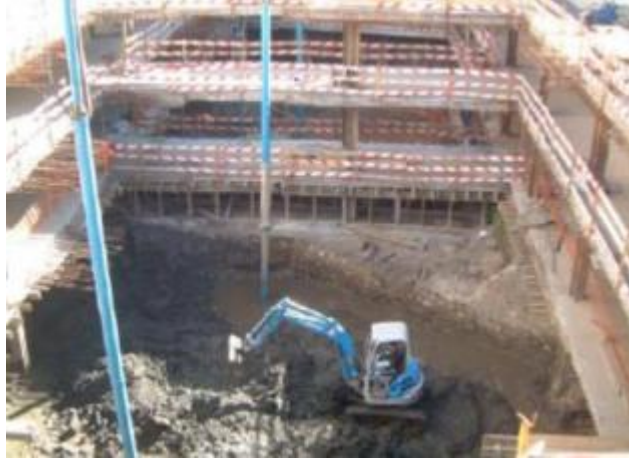
Figura 36- Contenção em top-down, através de bandas de laje [41].
