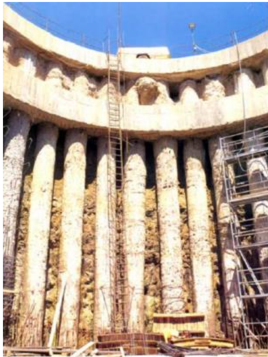
Figura 14- Cortina de estacas moldadas [16].
