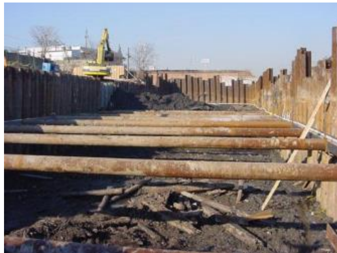
Figura 35- Representação de um escoramento de uma contenção [39].
