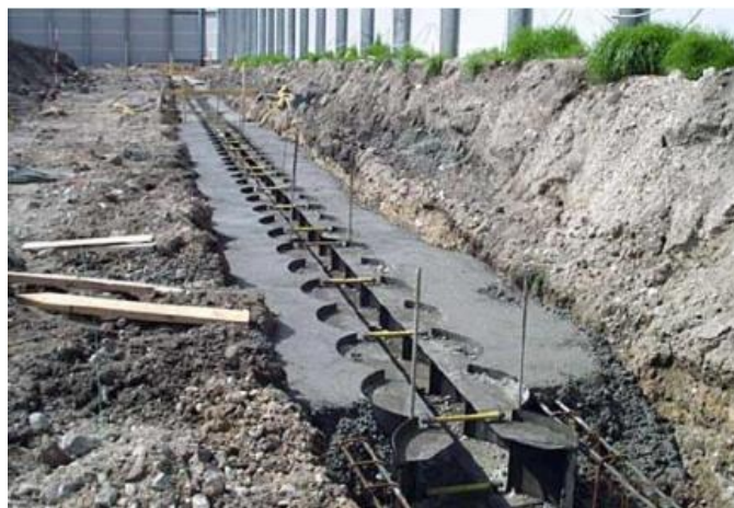
Figura 18- Execução de muros-guia [21].
