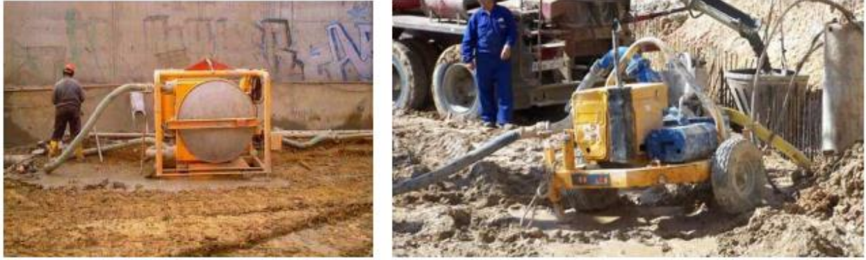
Figura 12- Vista de equipamentos de bombagem de lamas bentoníticas dos reservatórios para a escavação [14].
