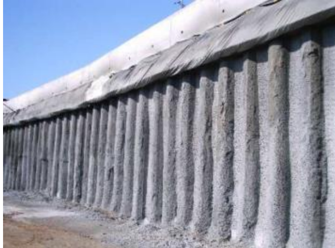
Figura 27- Vista em obra da parede regularizada com betão [30].
