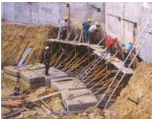
Figura 9- Pormenor de maciços de betão como reacção aos escoramentos da cofragem [10].
