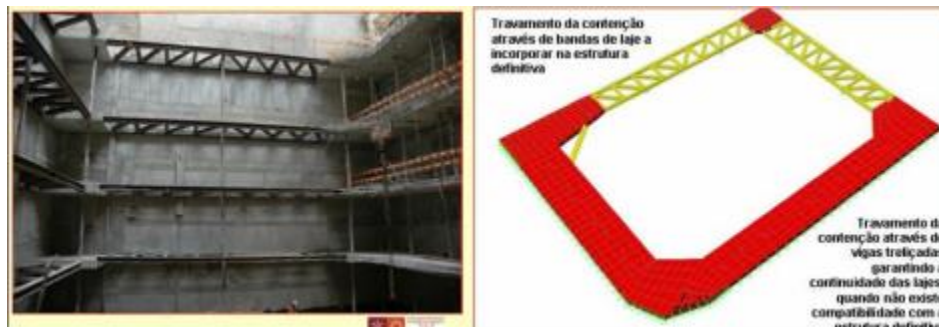
Figura 37- Exemplo de uso de bandas de laje, (Pinto, et al., 2008) [42].
