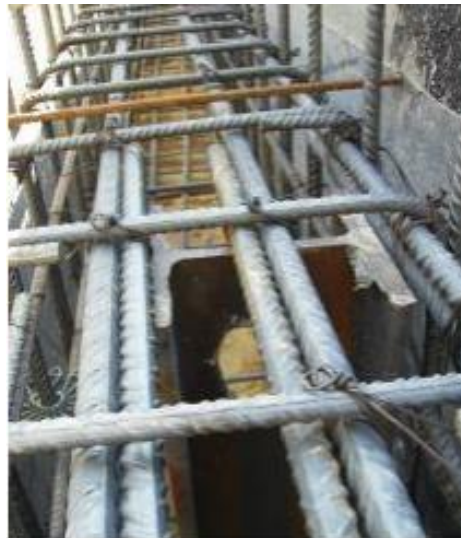
Figura 6- Perspectiva da armadura da viga de coroamento [7].
