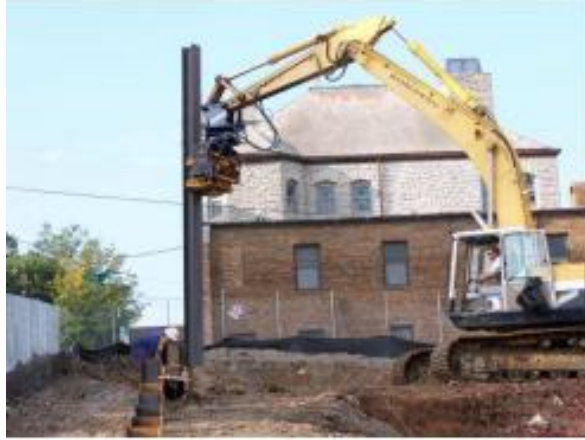
Figura 5- Cravação dos perfis metálicos no solo através de uma grua hidráulica [6].
