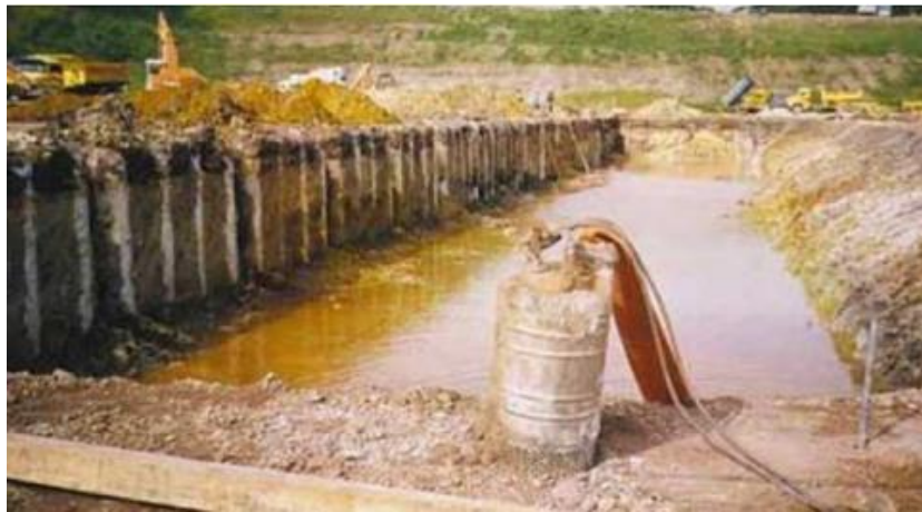
Figura 31- Bombagem com auxílio de mangueira de água no intradorso de uma cortina de estacas [34].
