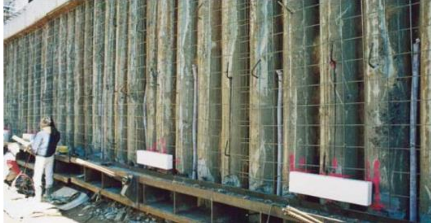
Figura 29- Cortina de estacas com drenos entre juntas [32].
