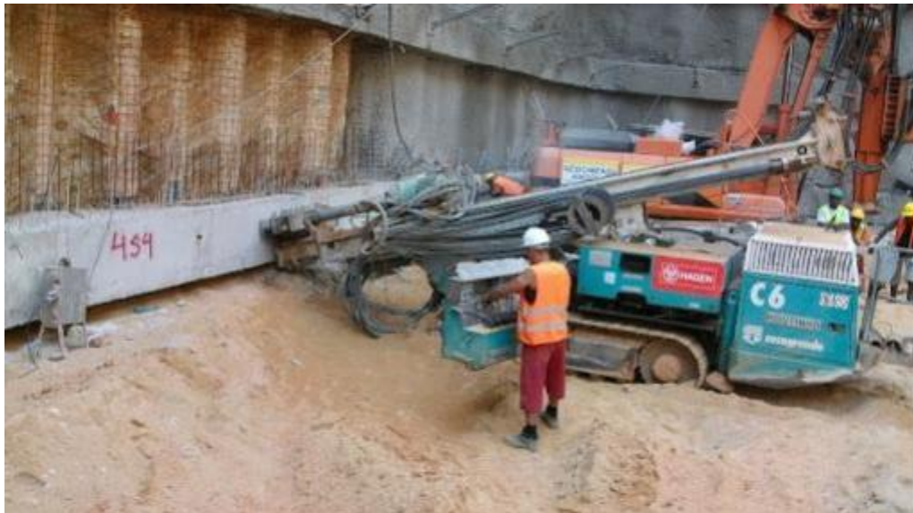
Figura 33- Aplicação de uma ancoragem numa contenção periférica [36].
