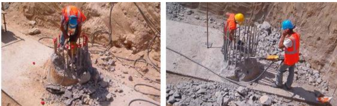
Figura 22- Remoção da cabeça da estaca contaminada com martelo pneumático [25].
