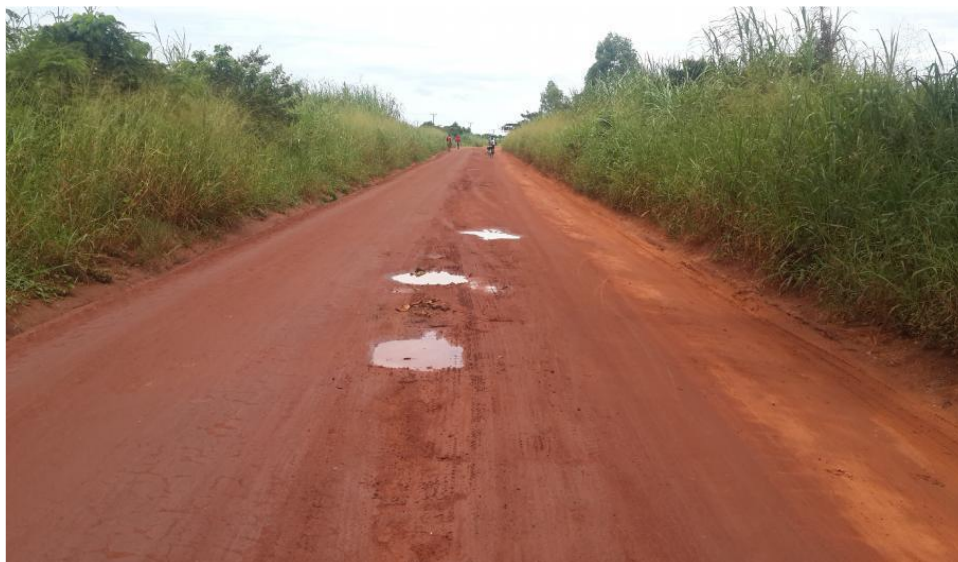
Figura 32: Buracos Fonte: (Autor, 2020)
