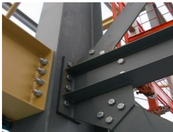
Figura 11. Ligação parafusada
