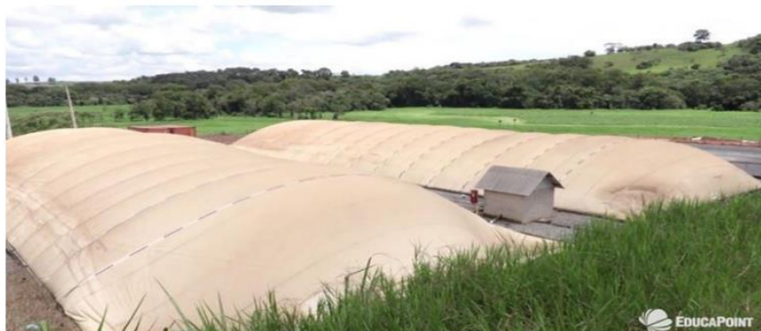
Figura 10: Sistema de biodigestor do modelo da marinha brasileira implementado.
