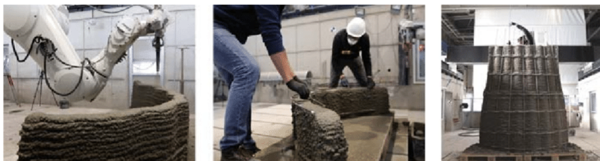
Figura 12: Sistema de construção modular com uso de equipamentos de impressora 3D
