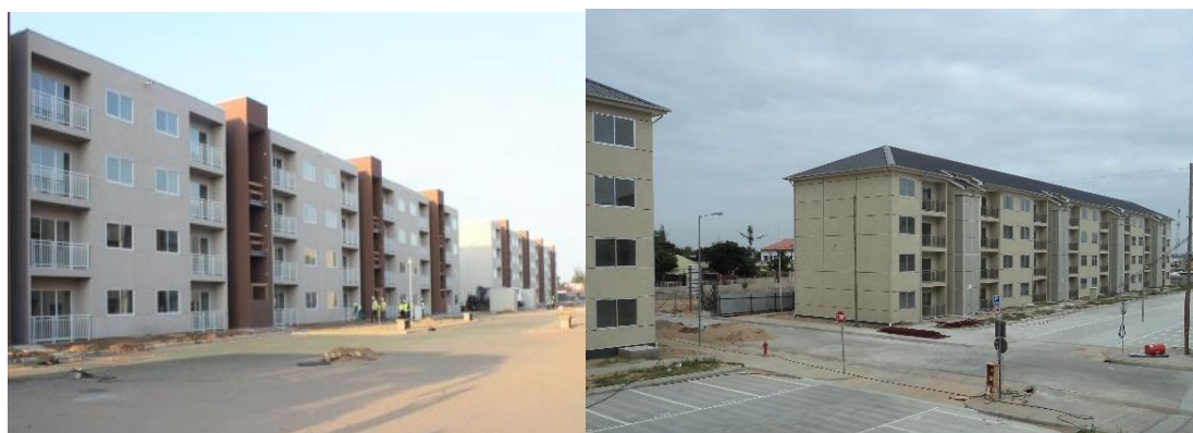
Figura 27: a) Fase 1 da construção da Vila Olímpica; b) Fase 2 da construção da Vila Olímpica
