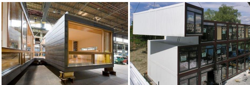
Figura 6: a) Módulo tridimensional em fábrica; b) Ligação dos módulos
