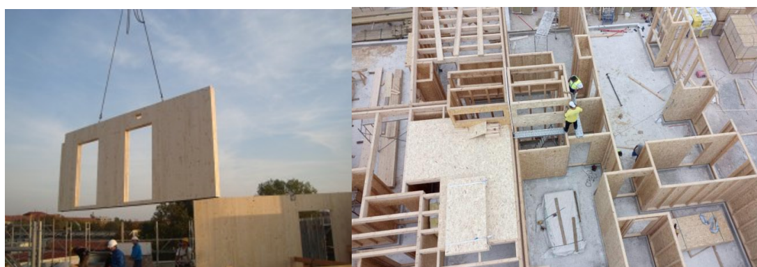
Figura 19: Construção modular em painéis de madeira CLT
