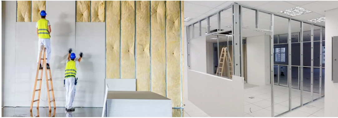
Figura 14: a) Montagem das placas de gesso (Drywall); b) Estrutura metálica de suporte para sistema Drywall
