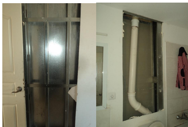
Figura 28: a) Interior da parede de um dos quartos; b) Interior da parede da casa de banho
