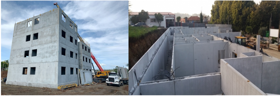
Figura 16: Construções em painéis de betão pré-fabricados
