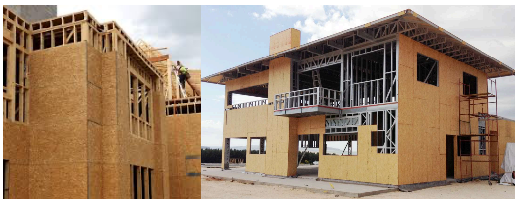
Figura 18: Construção modular em painéis de madeira OSB
