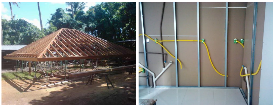
Figura 9: a) Cobertura pré-montada; b) Tubulação e acessórios hidráulicos na estrutura modular
