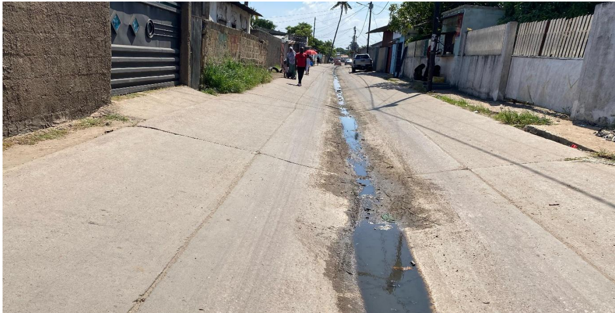
Figura 13. Sarjeta localizada na R. Eusébia de Silva Ferreira. (2025). Fotografia pessoal
