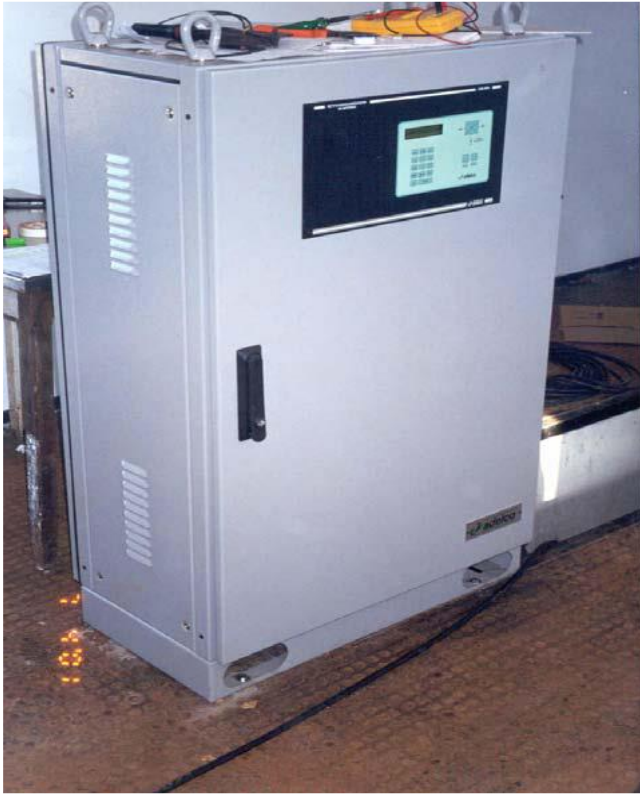
Figura 14: Rectificador /carregador
