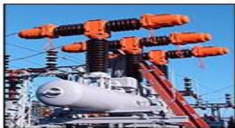
Figura 3: Disjuntor a Ar Comprimido 7,2 a 245 kV
