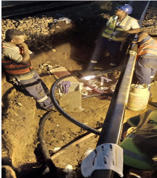
Figura 9: Técnicos manufacturando caixa de junção na alma ou por baixo da linha férrea durante a noite
