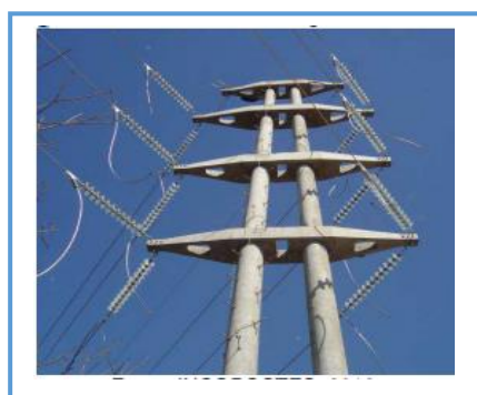
Figura 19. Estrutura de amarração ou ancoragem
