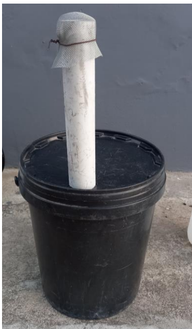
Figura 16: Balde com tubulação para ventilação
