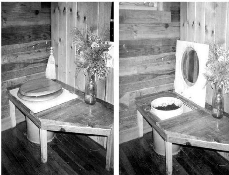
Figura 8: Exemplo de banheiro seco Humanure
