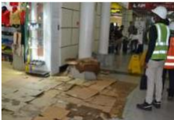
Figura 9 – Inspeção da Cobertura
