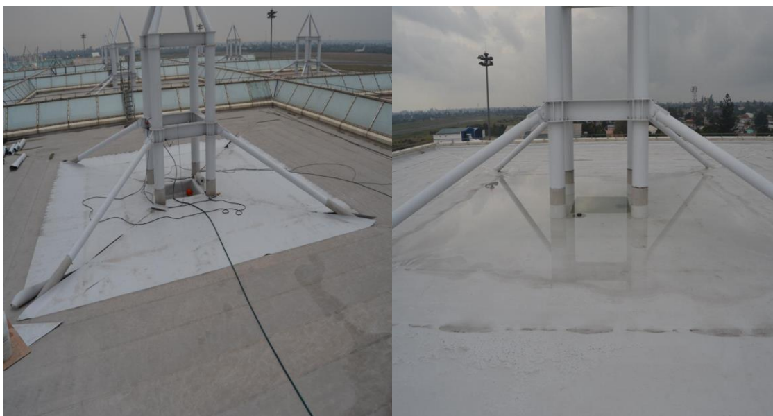
Figura 13 - Aplicação completa por cada quadrante, e começo do teste de estanqueidade
