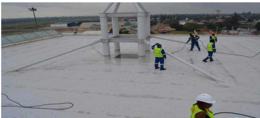
Figura 16 - Realização do teste de estanquidade
