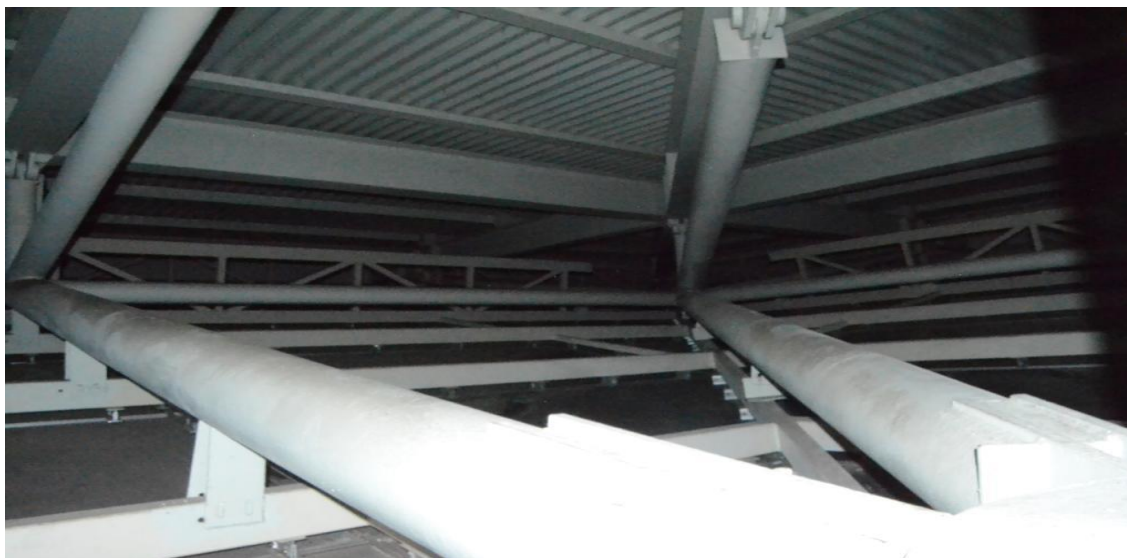
Figura 15 - Estruturas metálicas da cobertura
