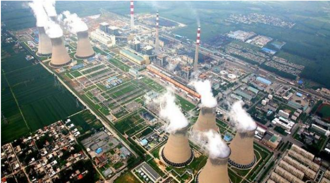
Figura 15: Imagem de uma Central Termoeléctrica (Central de Zouxian, China)
