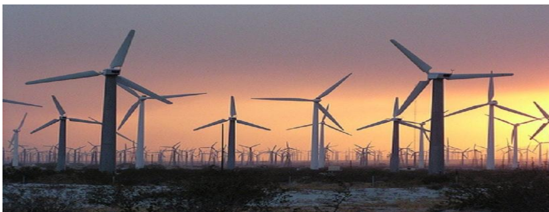
Figura 18: Imagem de um Parque Eólico
