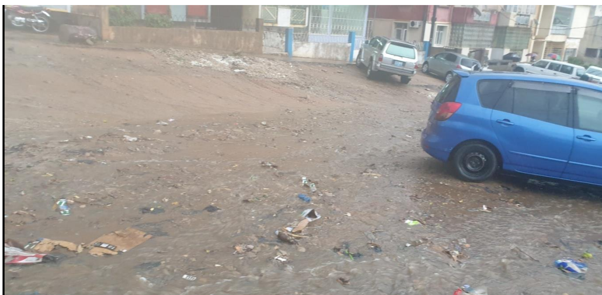
Figura 26 -Secção transversal inadequada na rua em estudo
