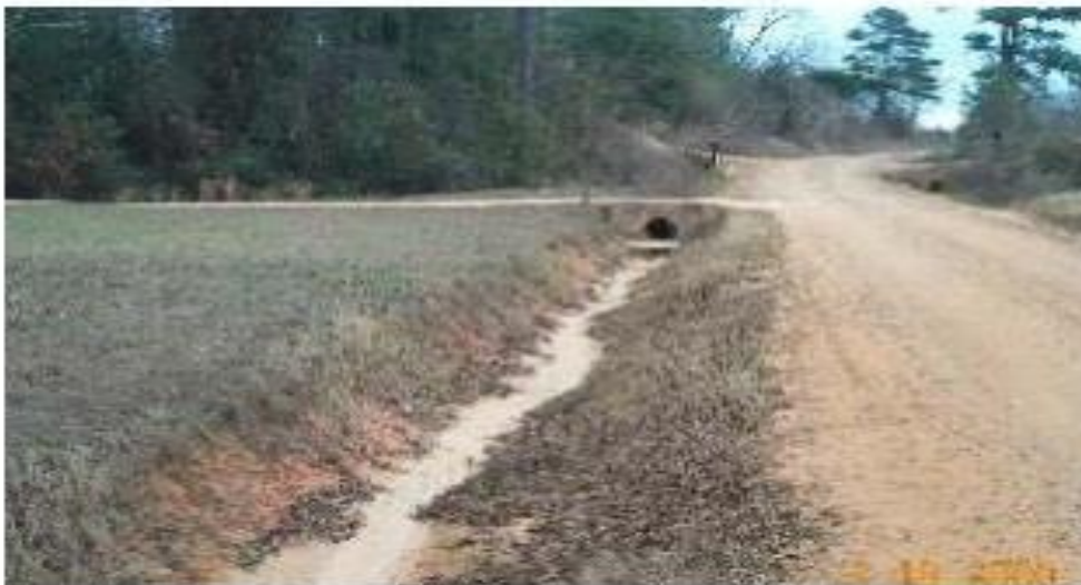
Figura 3 - Exemplo de uma sarjeta corretamente executada
