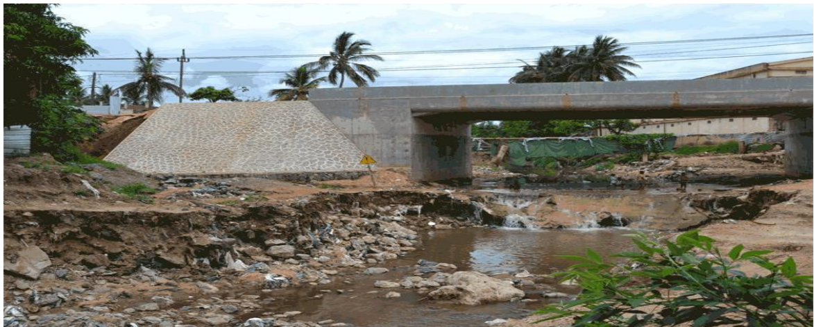
Figura 9: Encontro da ponte rio Muhala – cidade de Nampula
