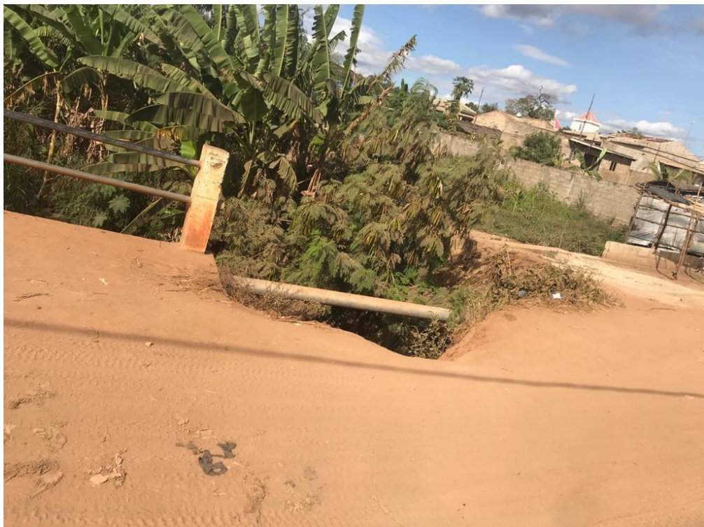
e) Aloimento de aterro.
