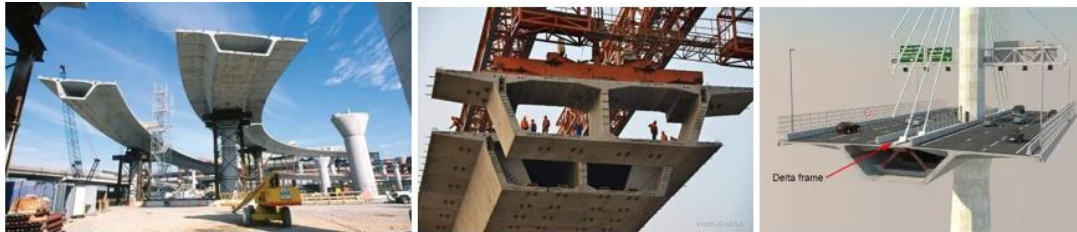
Figura 10: Estrutura secundaria e principal da ponte
