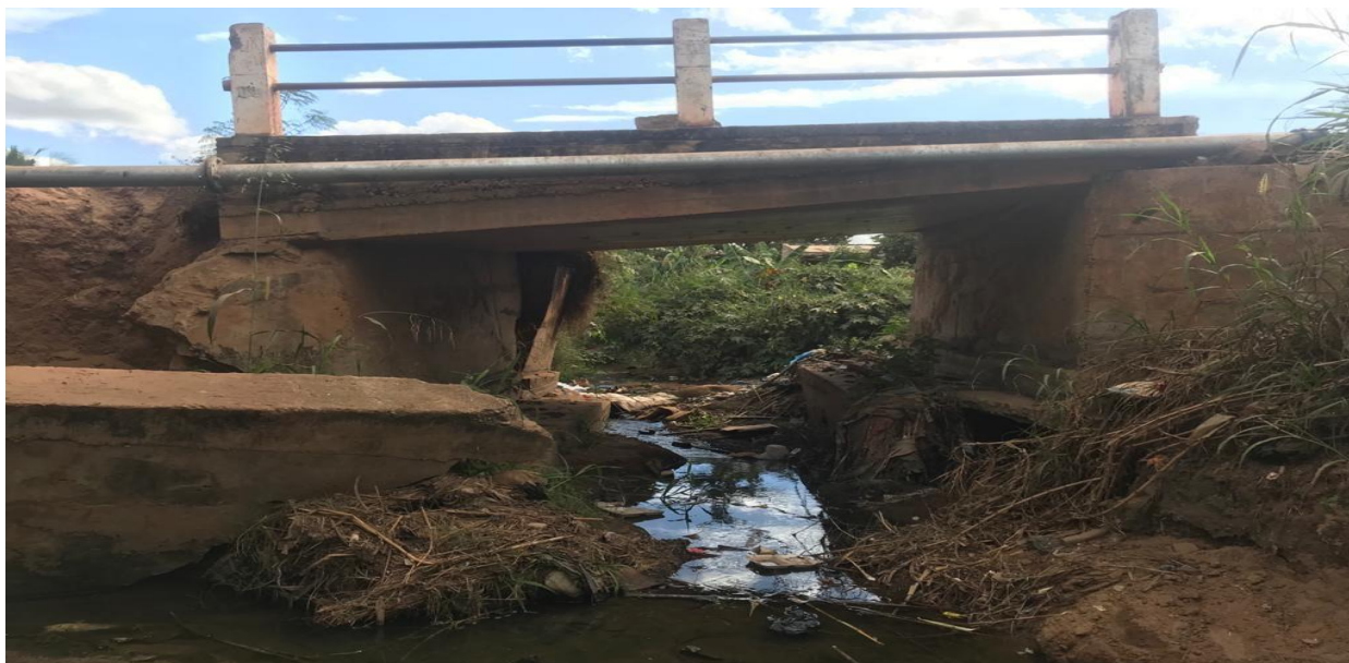
Figura 1: Ponte sobre o rio Reno
