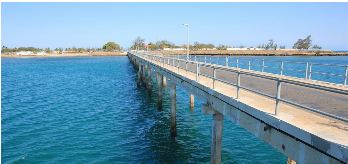
Figura 4: Ponte Ilha de Moçambique, Nampula
