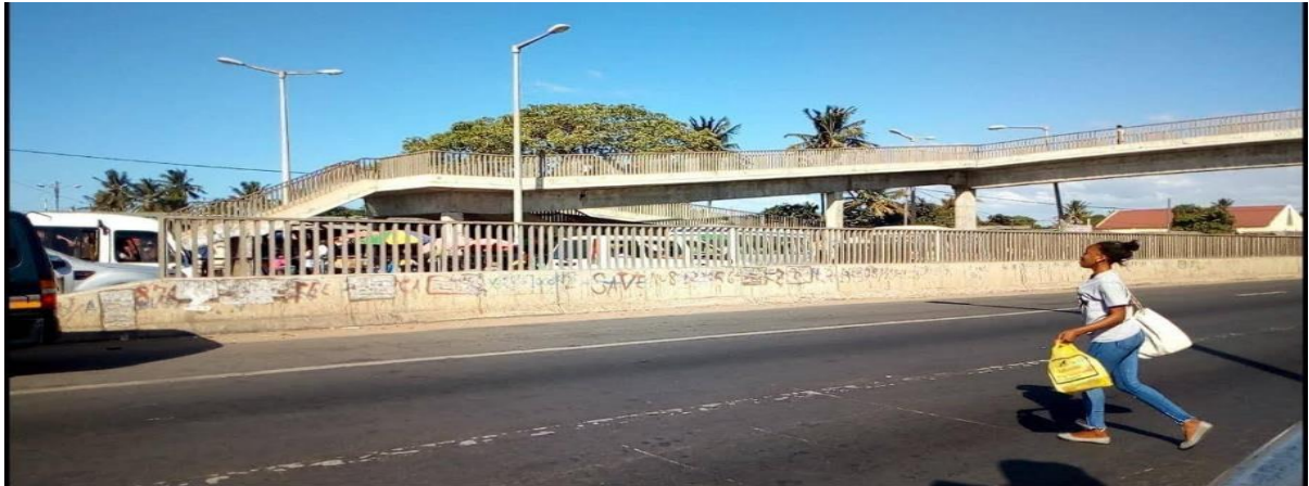
Figura 12: Passarela, cidade de Maputo
