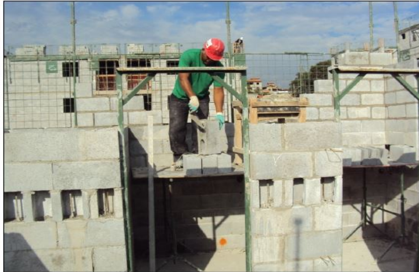
Figura 22: Aros metálicos para vãos de portas.
