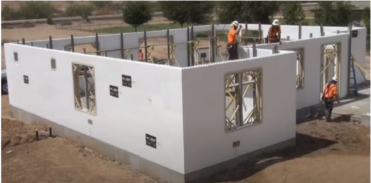
Figura 32: Paredes prontas para a betonagem.
