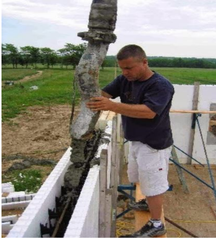
Figura 33: Betonagem da parede.
