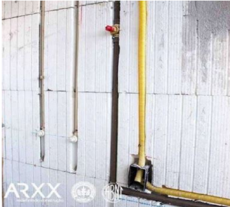
Figura 34: Corte para instalação eléctrica e hidráulica.
