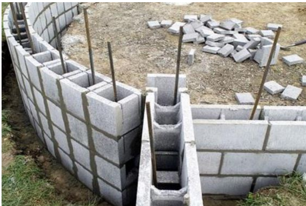
Figura 4: Alvenaria armada.
