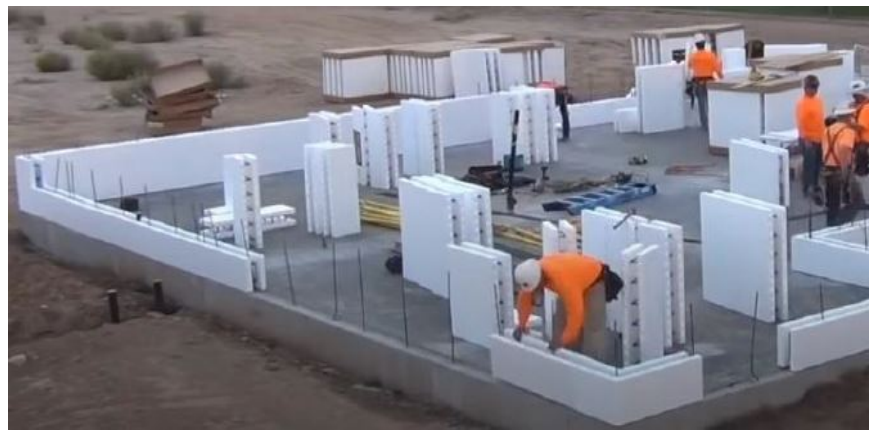
Figura 30: Colocação da primeira fiada.
