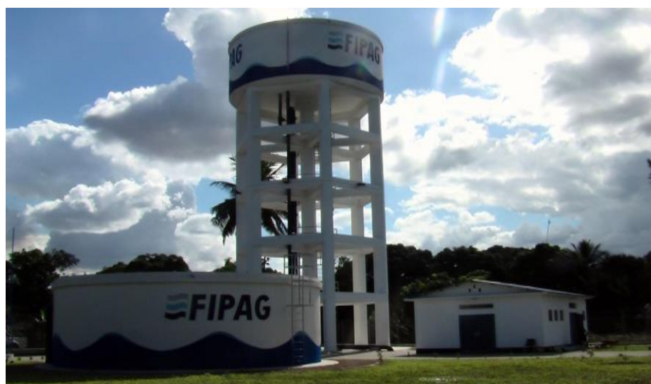
Figura 11: Reservatórios Semi-enterrado e Elevado
